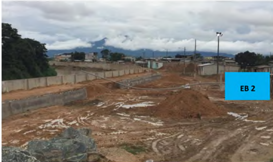
Gráfico 6: Ubicación estación de bombeo del subsistema 2
