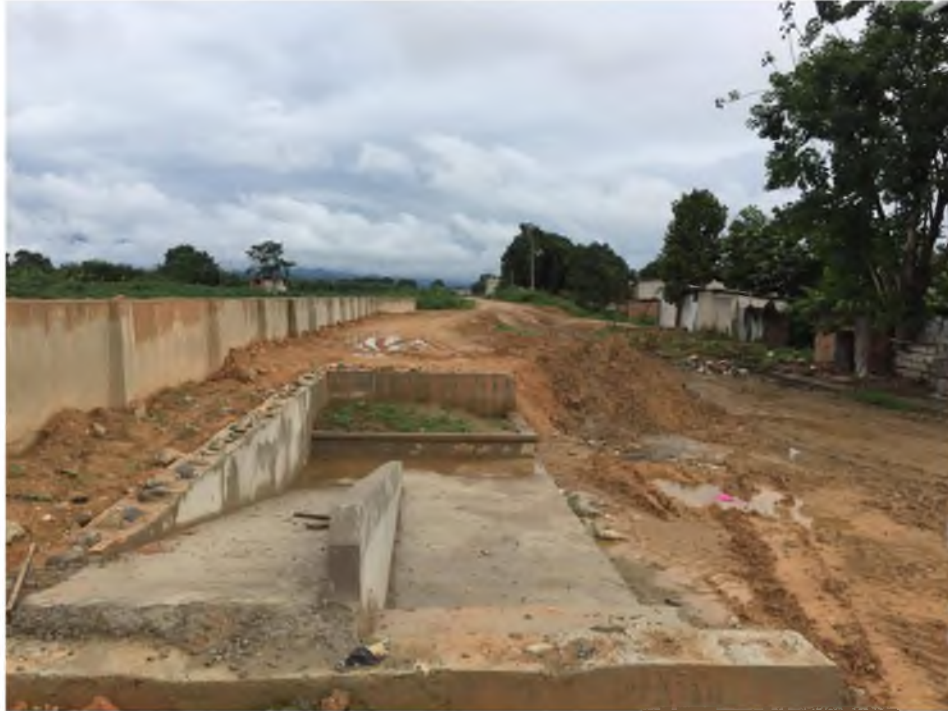
Gráfico 1: Muro para el control de inundaciones
