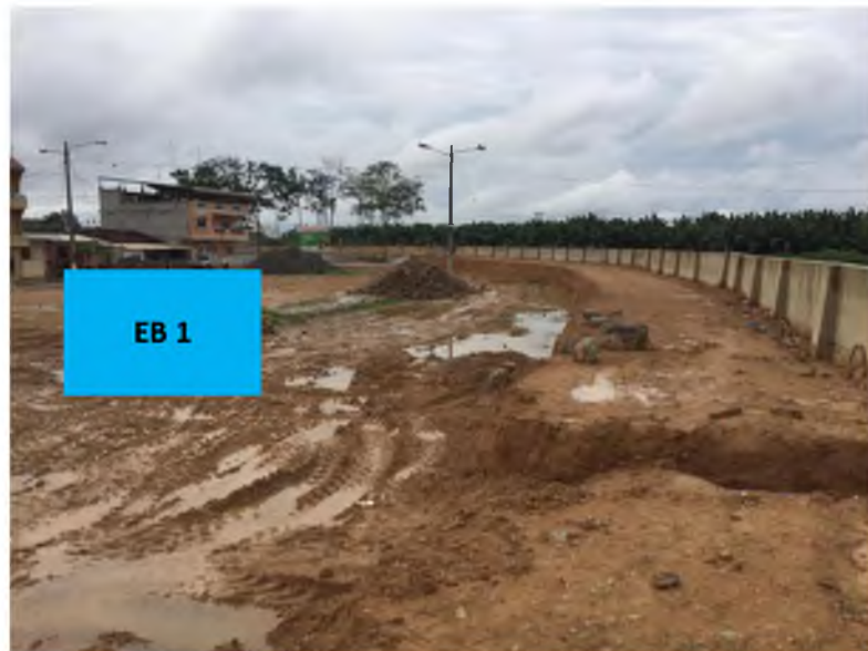
Gráfico 5: Ubicación estación de bombeo del subsistema 1
