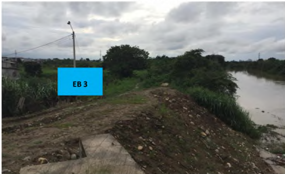
Gráfico 7: Ubicación estación de bombeo del subsistema 3
