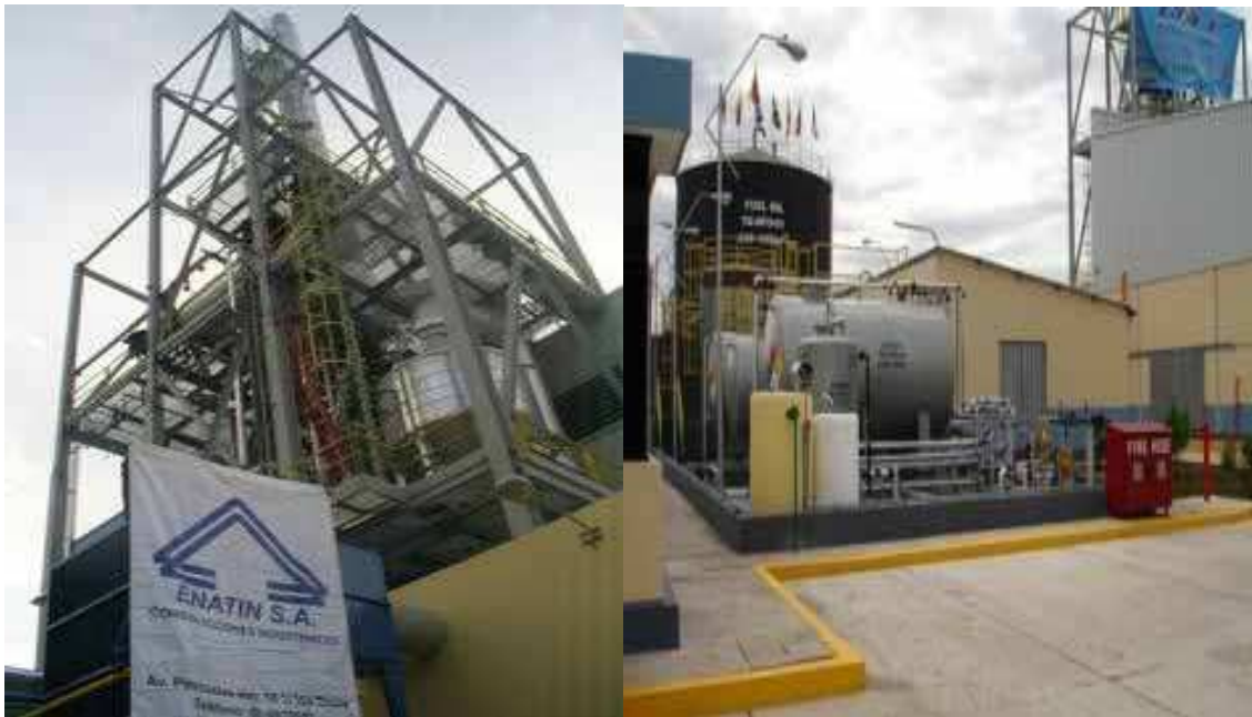
Foto 5: Fabricación y montaje de estructuras y tanques para proyecto termoeléctrico Emelsucumbios Fuente: www.enatin.com
