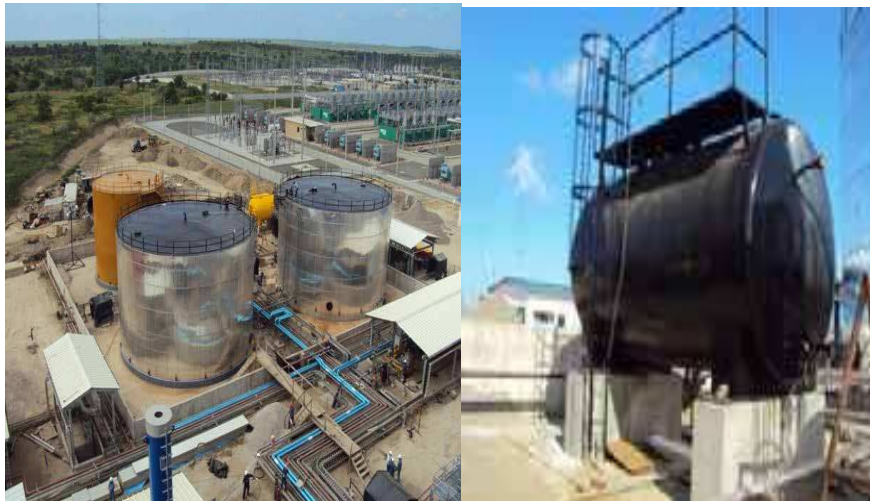
Foto 10: Tanques de almacenamiento Central Térmoelectrica Santa Elena 3 Fuente: www.enatin.com
