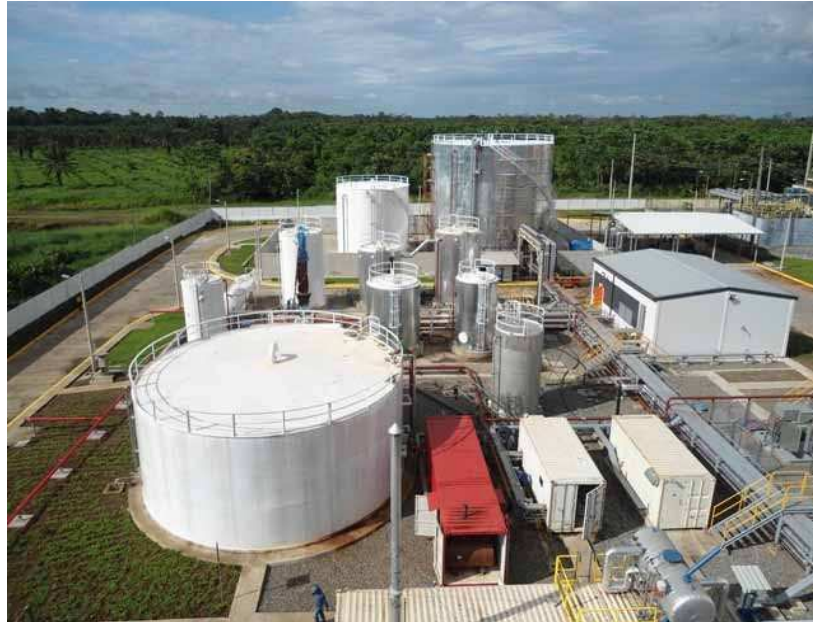
Foto 11: Tanques de almacenamiento Central Termoeléctrica Jivino Fuente: www.enatin.com
