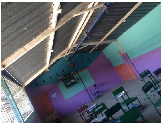
Figura 15: techo no presenta ventiladores Fuente: elaboración propia
