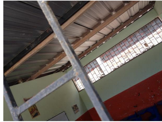
Figura 14: techo o presenta luminarias Fuente: elaboración propia
