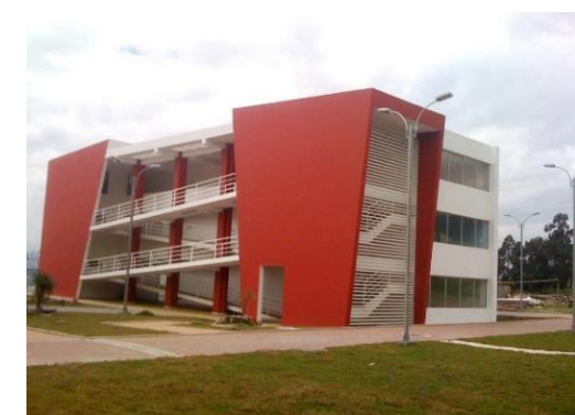
Figura 34: Edificación del colegio Fuente: Skyscrapercity, (2012)
