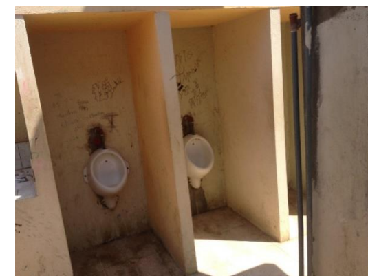
Figura 11: urinarios del baño de los hombres Fuente: elaboración propia
