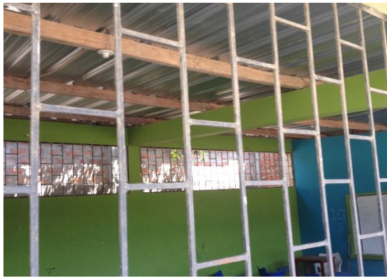
Figura 13: techo no presenta luminarias Fuente: elaboración propia
