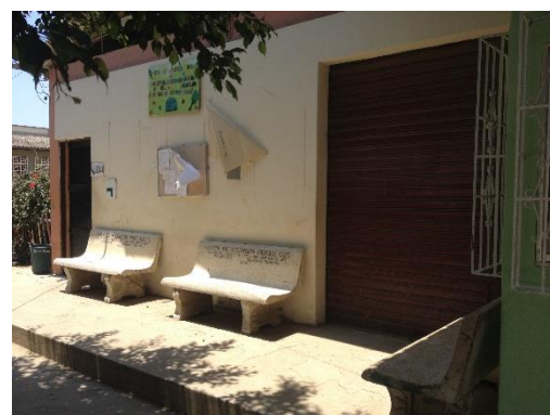
Figura 6: altura de la acera para la inspección Fuente: elaboración propia
