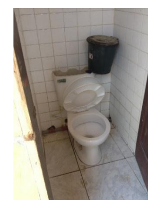
Figura 12: SS.HH del baño de mujeres Fuente: elaboración propia
