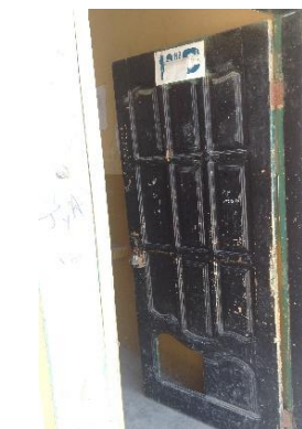
Figura 3: puerta de aula Fuente: elaboración propia
