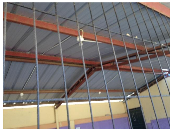
Figura 16: techo no presenta ventiladores Fuente: elaboración propia
