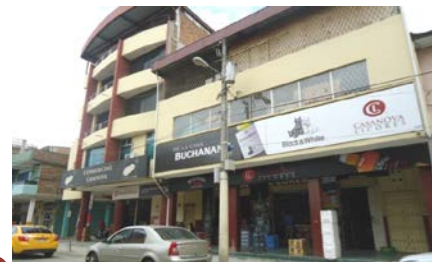
FIGURA 8. COMERCIAL CASANOVA UBICADO EN LA CALLE CÓRDOVA
