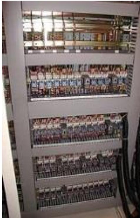
Figura 1. 5: Tablero de control con lógica cableada
