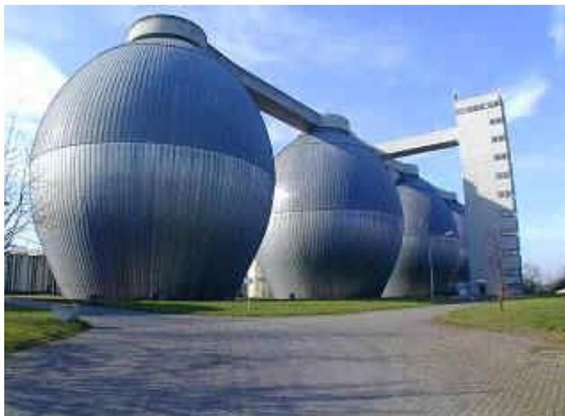
**Ilustración 2. La digestión de los lodos de manera anaeróbica. Fuente: (klaerwerk-online.de)**
