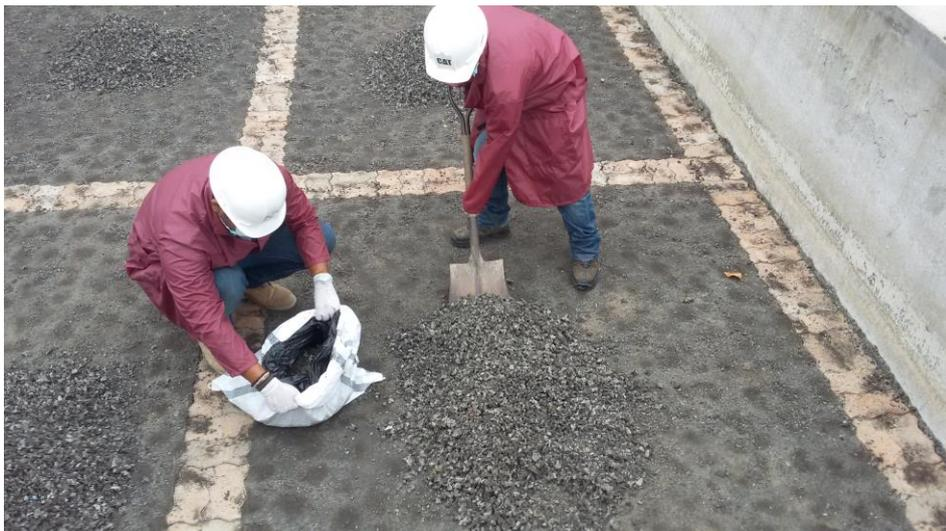
**Ilustración 7. Recolección de los lodos, con un porcentaje de humedad alrededor del 6-8%. Fuente: Autor**
