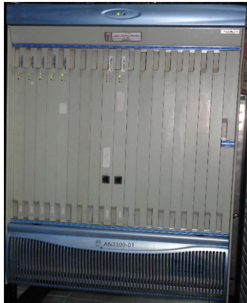
Figura 2 61: Equipo Dslam.
