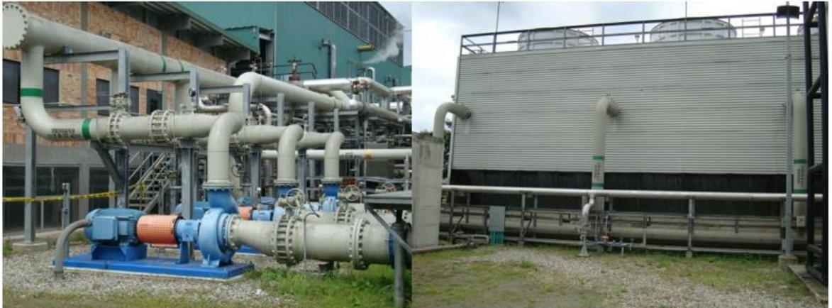
Figura 3. 7: *Bombas de Agua de Circulación y Torres de Enfriamiento.*
