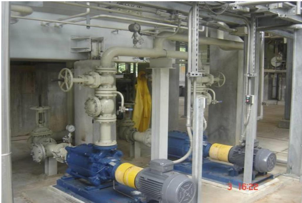
Figura 3. 18: *Bombas de agua de condensado.*
