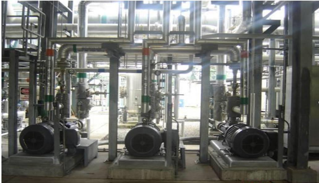
Figura 3. 15: *Bombas de Agua de Alimentación de Calderas.*
