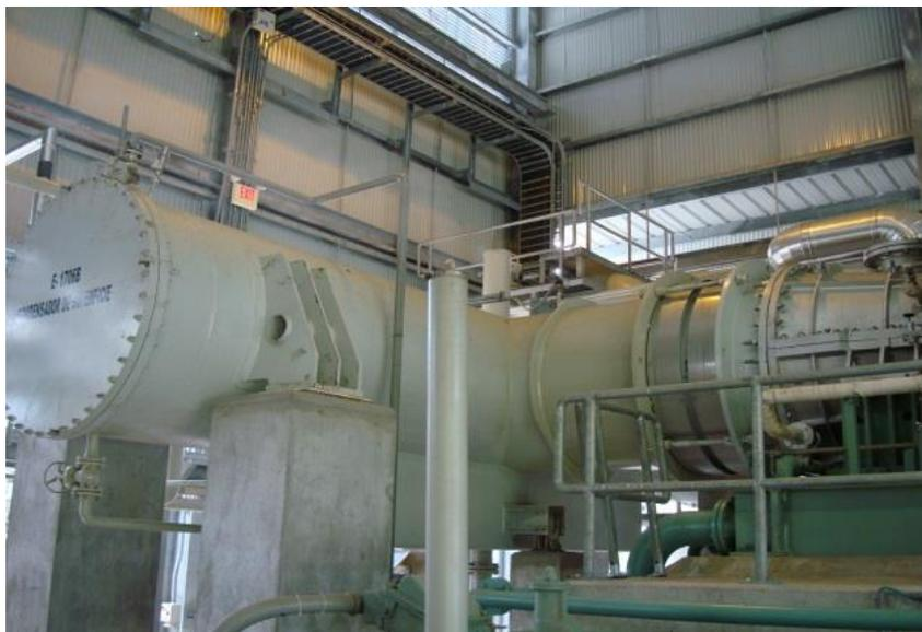
Figura 3. 4: *Condensador GEA.*
