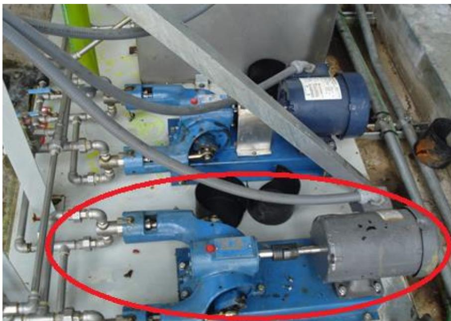
Figura 3. 6: *Bomba de Inyección de Químicos al Desaireador.*
