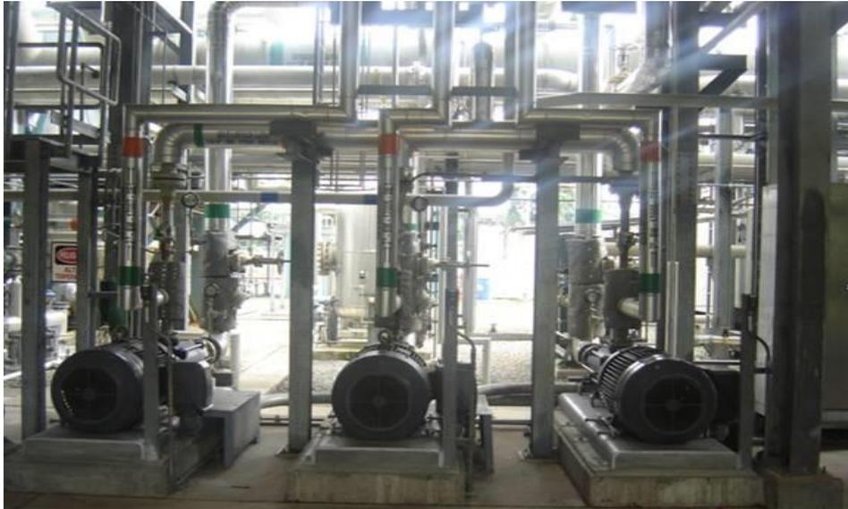
Figura 3. 5: *Bombas de Agua de Alimentación de Calderas.*
