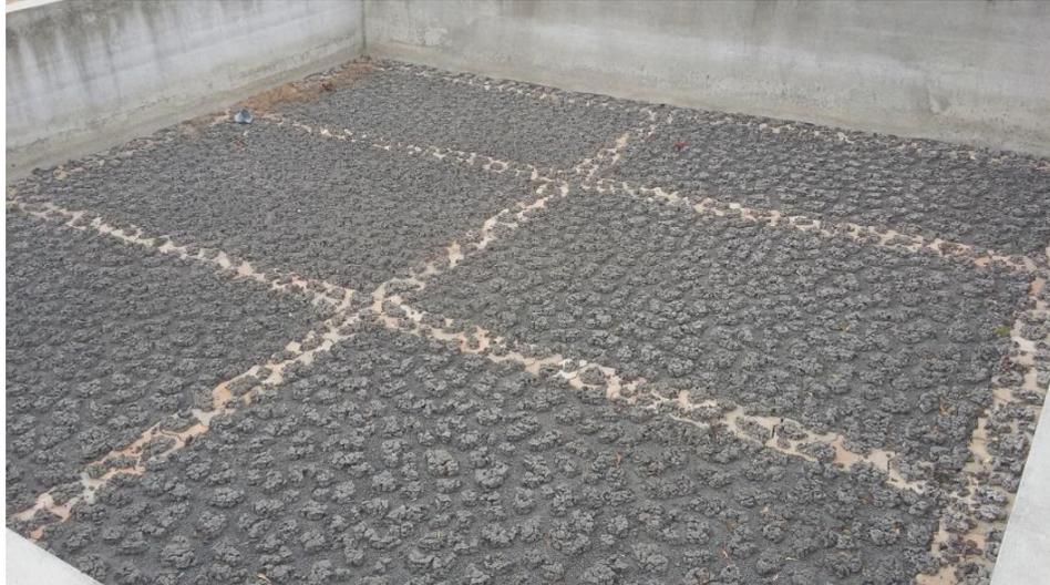
**Ilustración 19. Piscinas de tratamiento de lodos residuales para extracción de los lodos residuales (material tipo B)**
