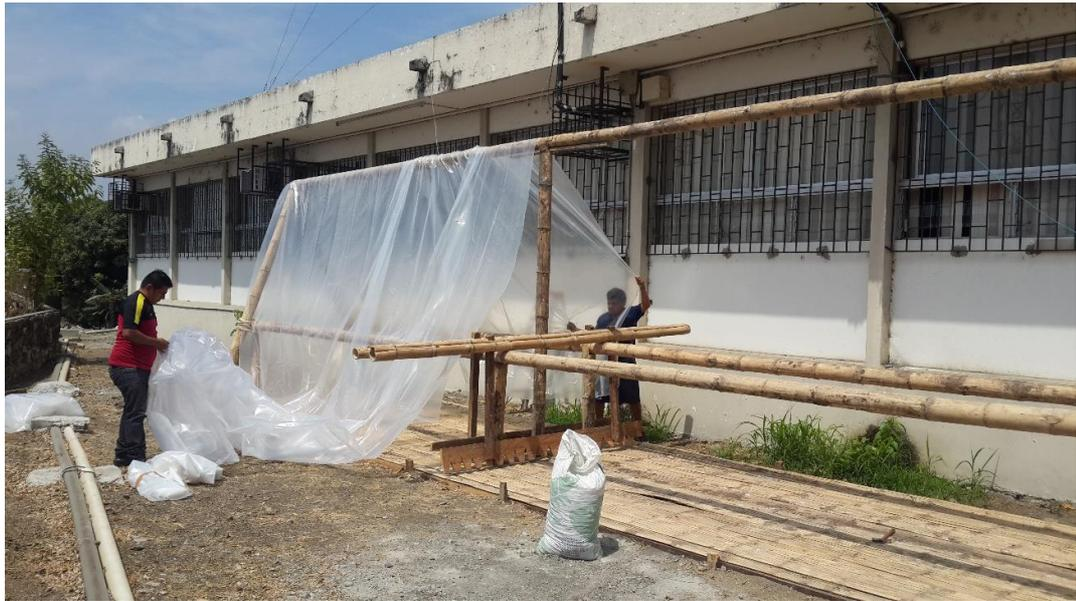
**Ilustración 8. Montaje y colocación del plástico.**
