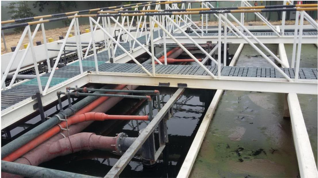
**Ilustración 15. Sistema de tratamiento de aguas residuales (Urbanización La Joya) para extracción de lodos residuales (Material tipo B).**
