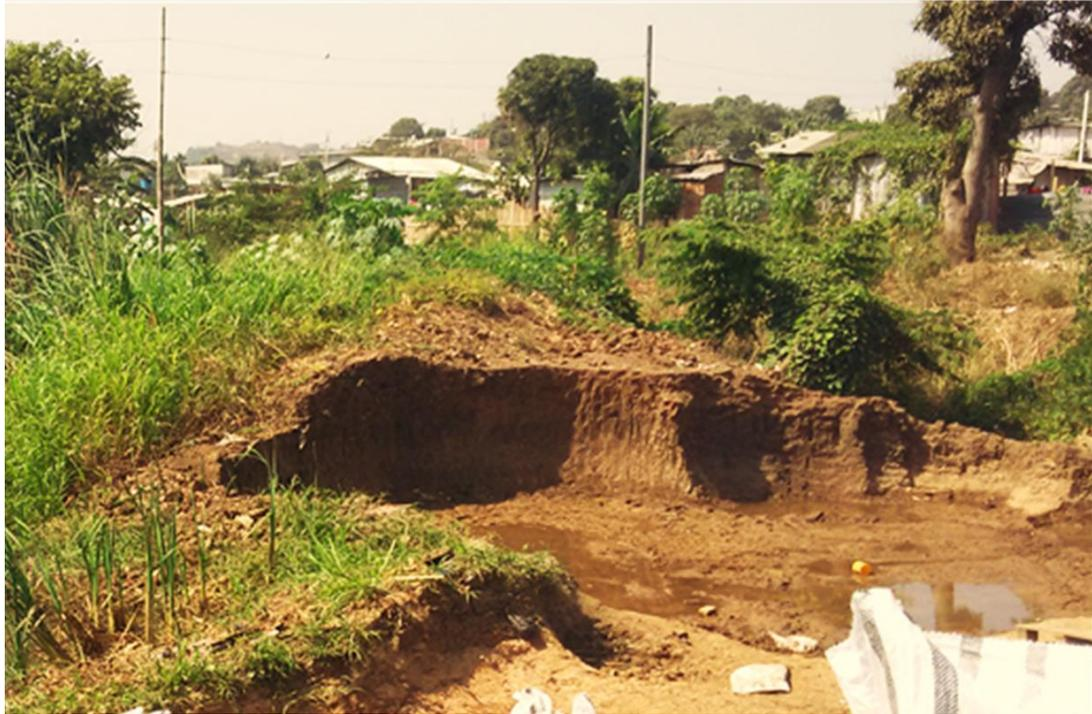
**Ilustración 11. Sitio para la extracción de la arcilla expansiva (material tipo A).**
