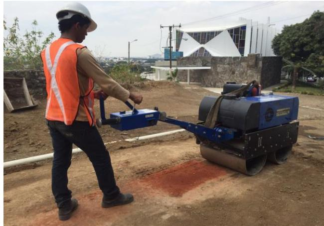
**Ilustración 49. Grava granulométrica, arena más grava de arcilla con adiciones de lodos residuales en sub-base de vías.**
