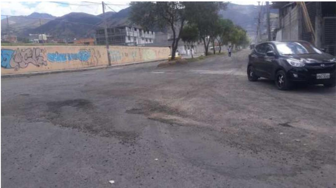
**Figura 2.8. Desprendimiento en pavimento**
