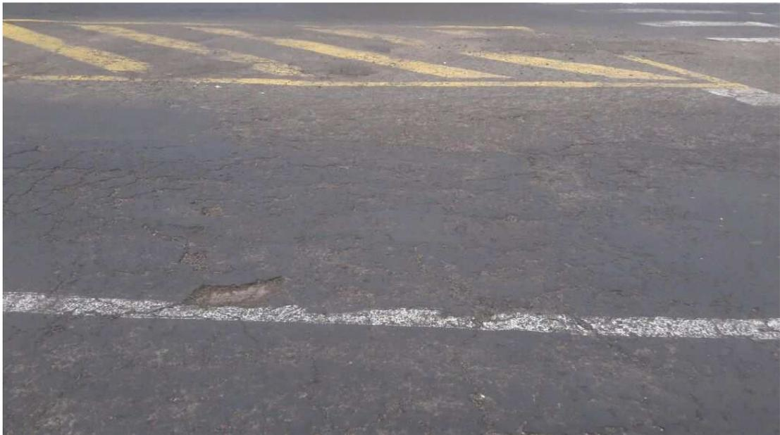
**Figura 1.2. Peladura en capa asfáltica**
