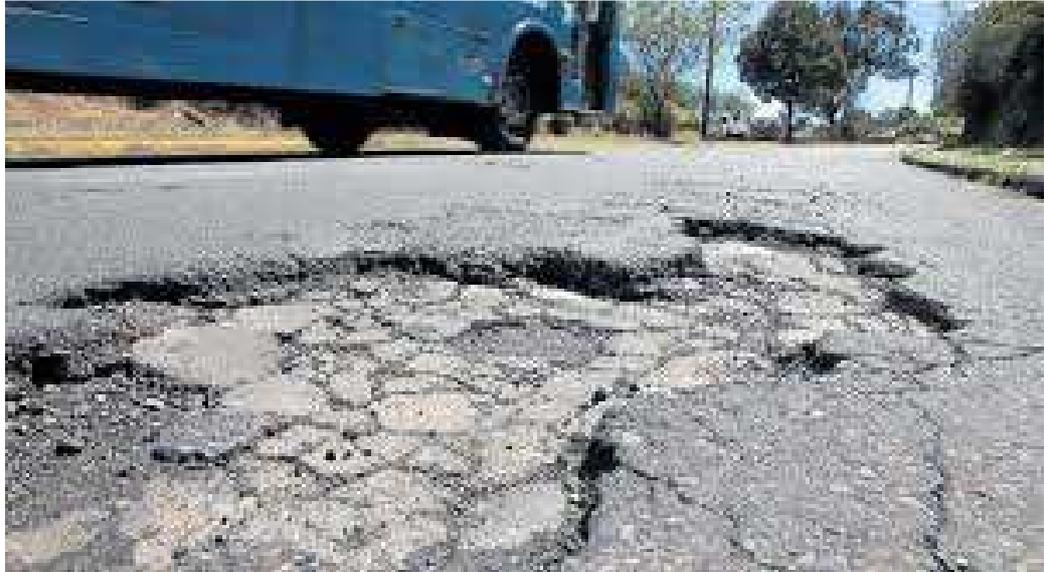
**Figura 1.1. El pavimento de la av. Cardenal de la Torre, sur de Quito, tiene fisuras y huecos.**
