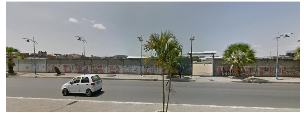
Figura 4: Vista general desde calle Amazonas
