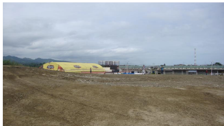
3. Vista hacia la terminal desde la cota más alta del terreno, orientación suroeste.
