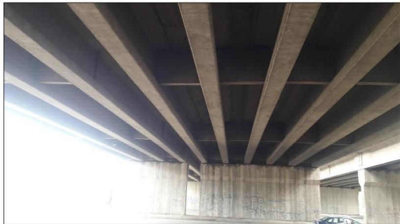
Figura 13: Características de la viga del paso elevado av. Francisco de Orellana intersección perimetral
