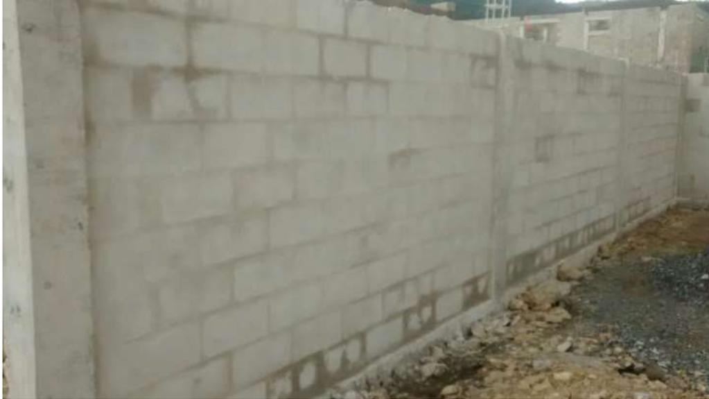
**Figura N° 25 Proceso constructivo, Levantamiento de pared en obra**
