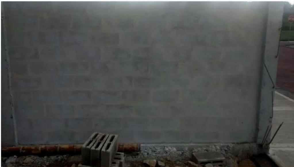
**Figura N° 26 Levantamiento de pared en obra (2.00m x 3.60m)**
