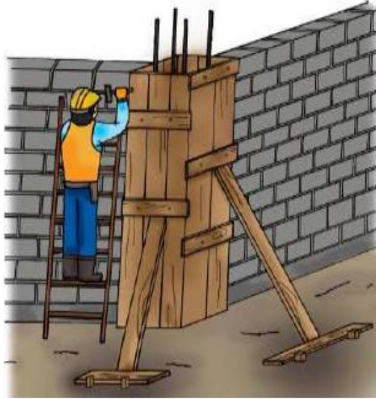
Figura 33 Encofrado de Columnas
