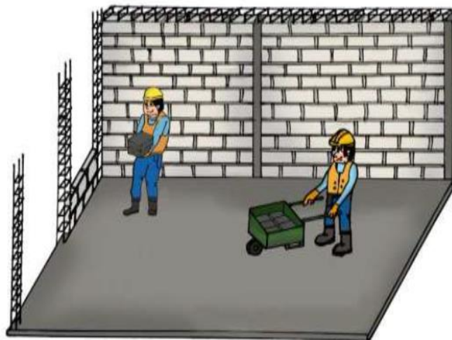
Figura 54 Pared de mampostería Confinada, Tipo 1
