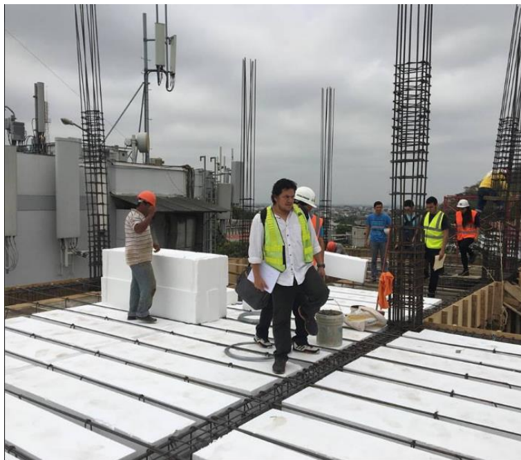
Figura 47 Armado de Losa en 1 Dirección
