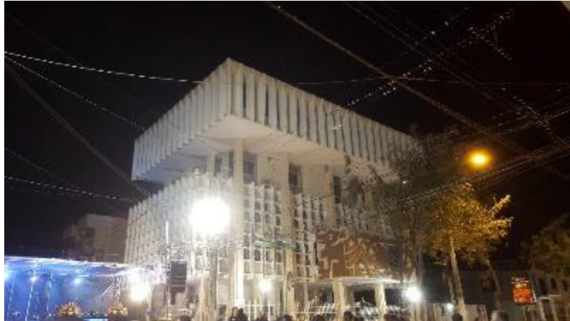
Figura 134 Fallas del Edificio Municipal
