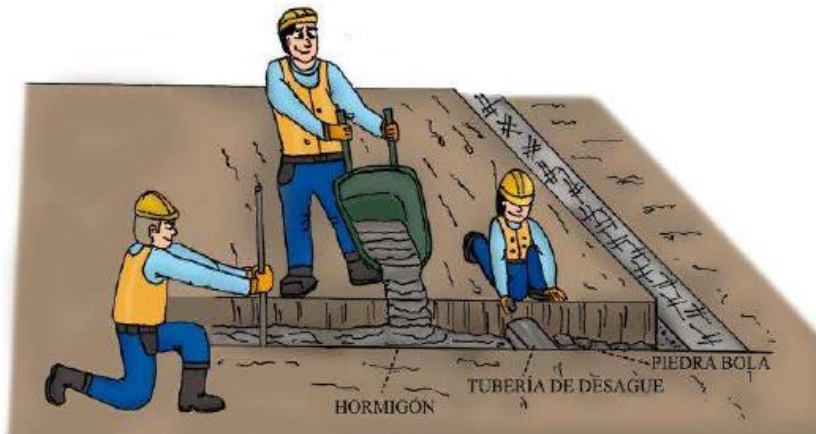
Figura 25 Fundición del Cimiento de la Riostra.
