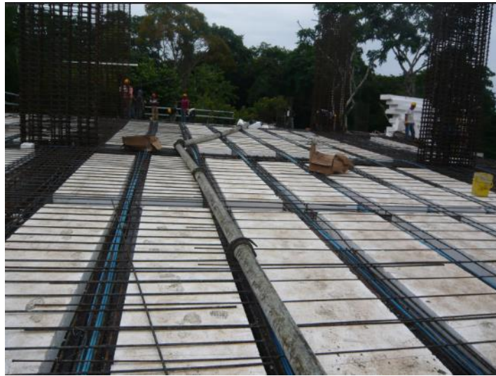
Figura 5 Losas alivianadas con Poliestireno Expandido
