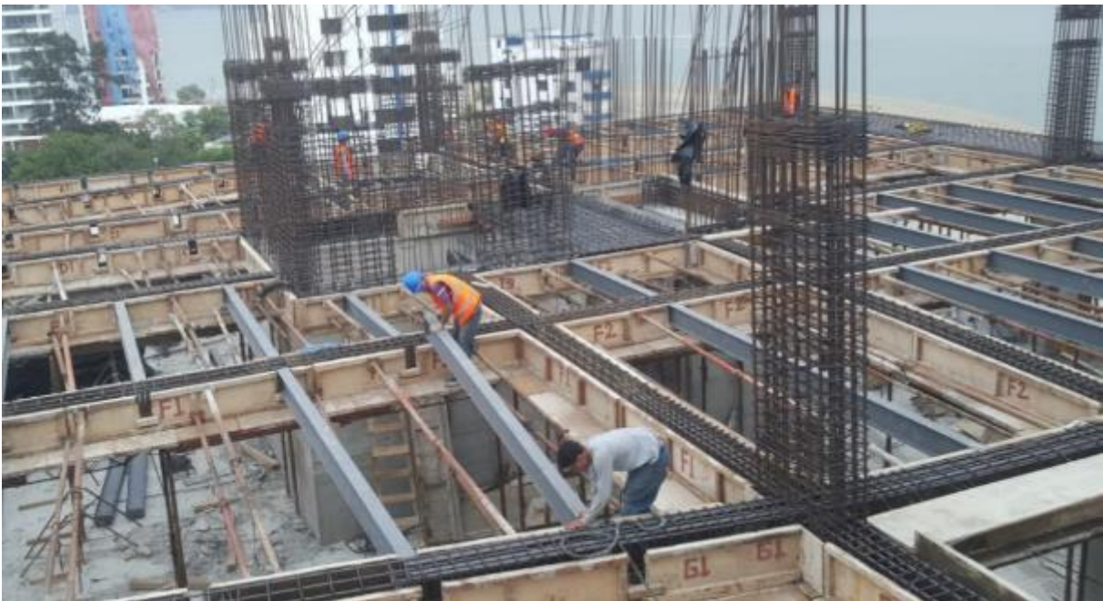
Construcción Mixta de Hormigón con estructura Metálica – alado Edificio La Fragata
