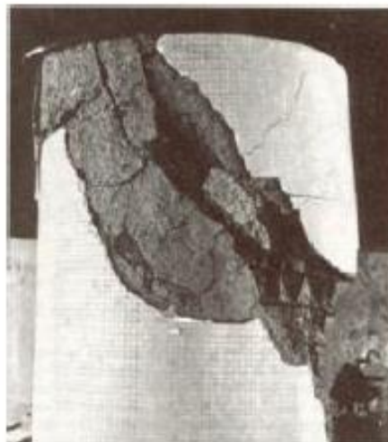
Figura 74 Típicas fallas en columnas por fuerzas sísmicas
