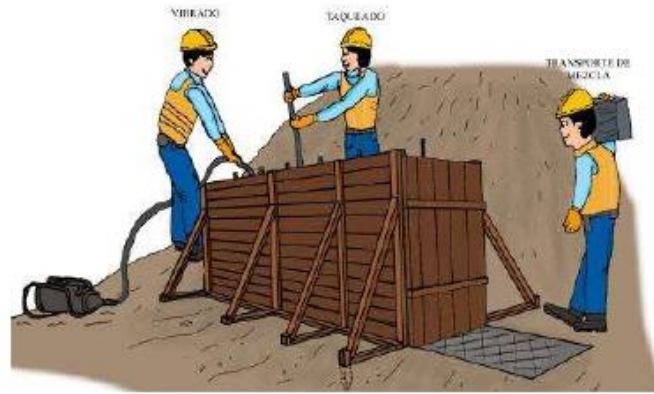
Figura 22 Fundición del Muro de Contención
