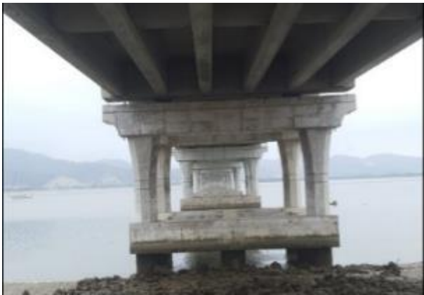
Puente las Caras conecta Bahía con San Vicente – Apoyos con Aisladores Sísmicos
