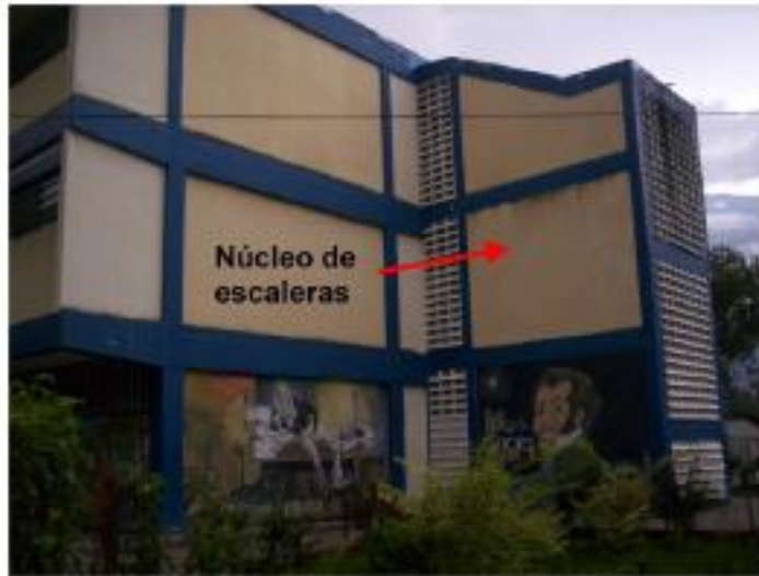
Figura 88 Posibles Efectos Torsionales por Escaleras
