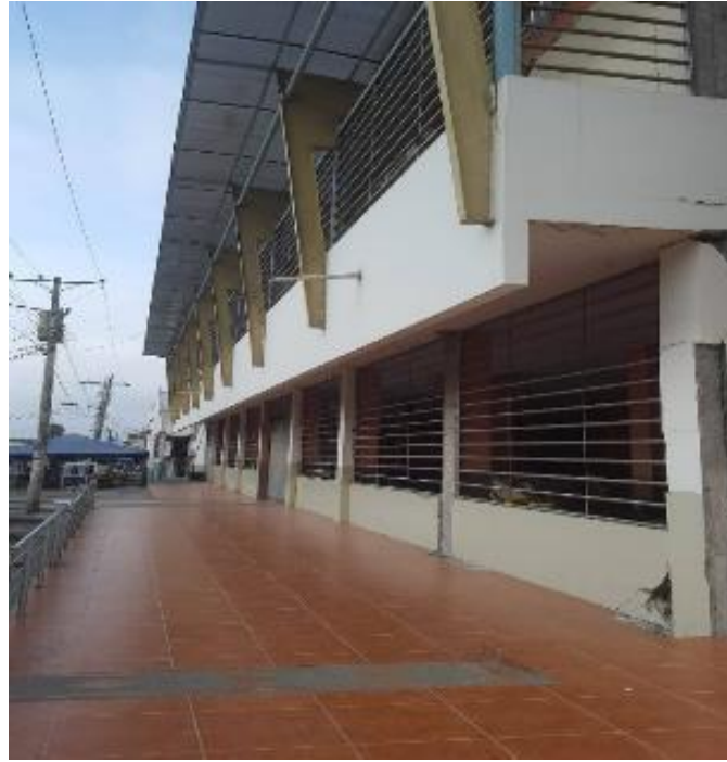
Figura 114 Fachada sobre principal del Mercado Municipal
