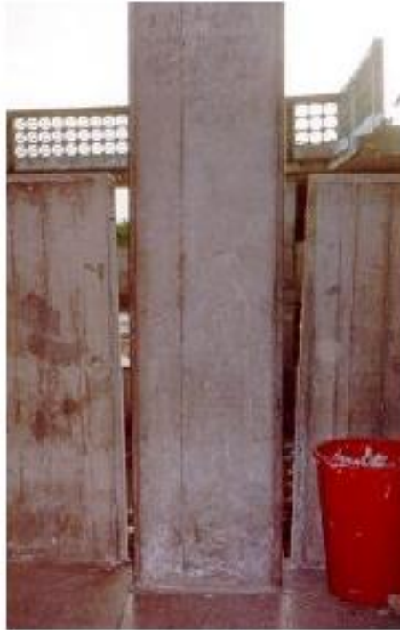
Figura 101 Separación de Columnas con los demás Elementos
