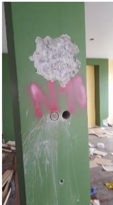
Figura 104 Pruebas de Extracción de núcleo Edificio Jalil
