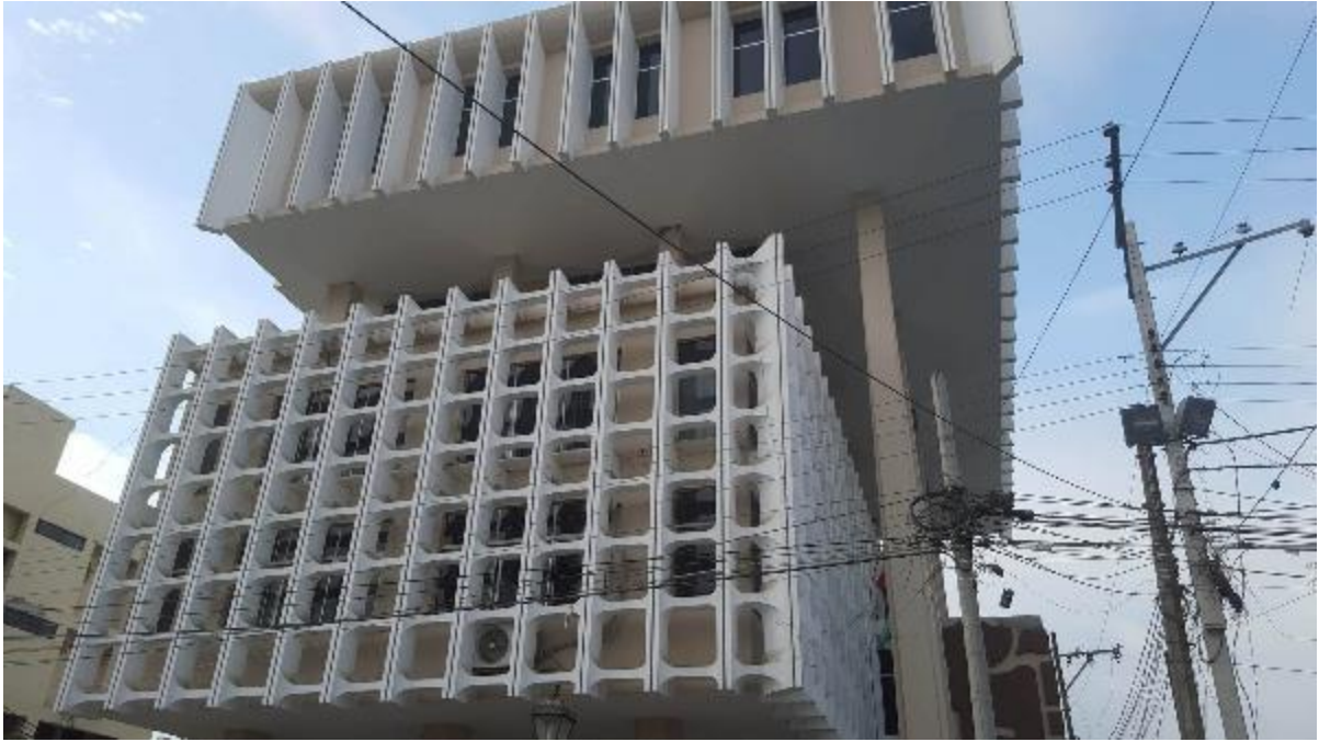
Figura 106 Fachada sobre la Calle Ascazubi – Edificio Municipal
