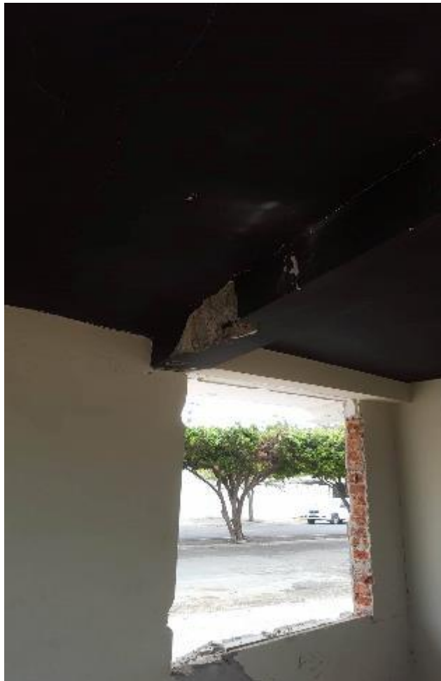
Figura 128 Generación Rótulas Plásticas en vigas – Edificio Jalil
