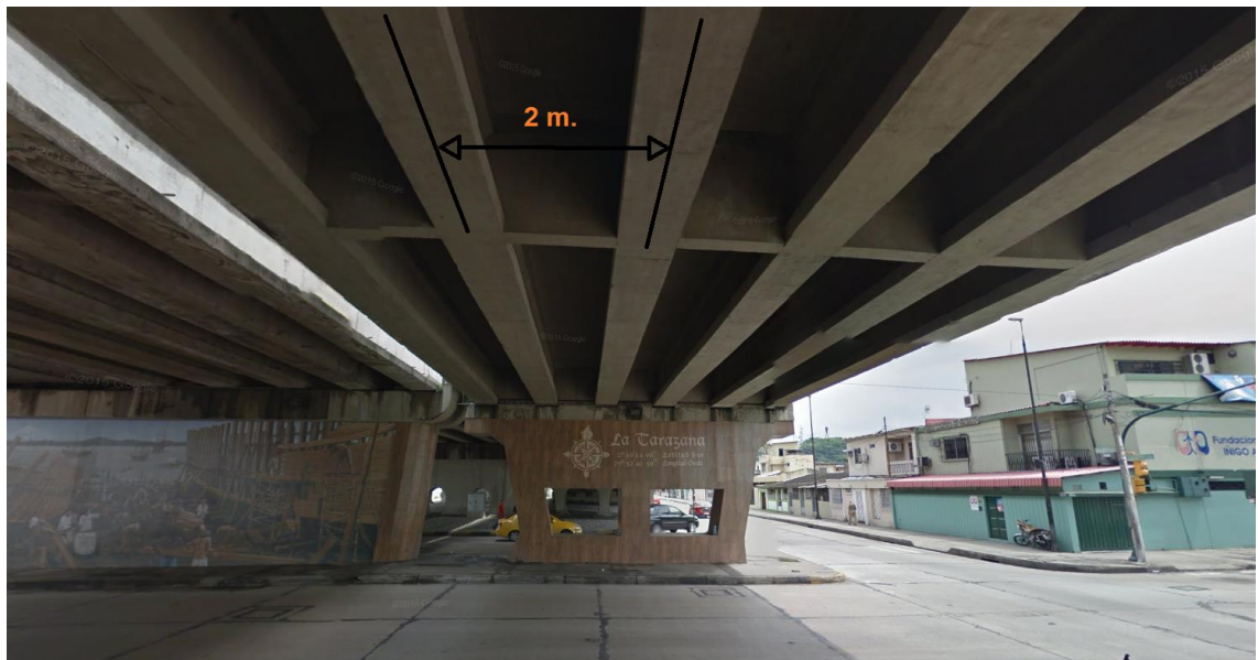
Figura 12: Separación entre vigas de puente en La Atarazana
