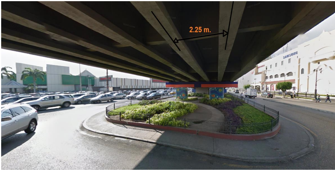
Figura 7: Ancho de tablero de puente frente a C.C. San Marino
