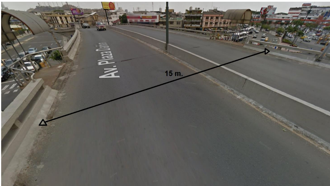
Figura 7: Ancho de tablero de puente frente a C.C. San Marino
