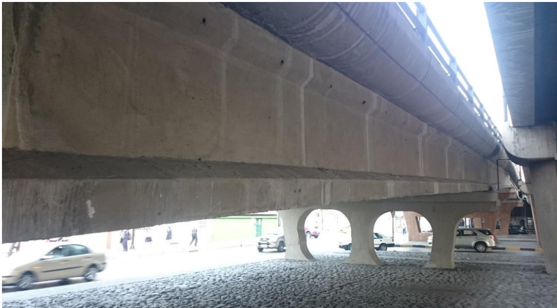
Figura 9: Vista cercana de viga de puente en La Atarazana
