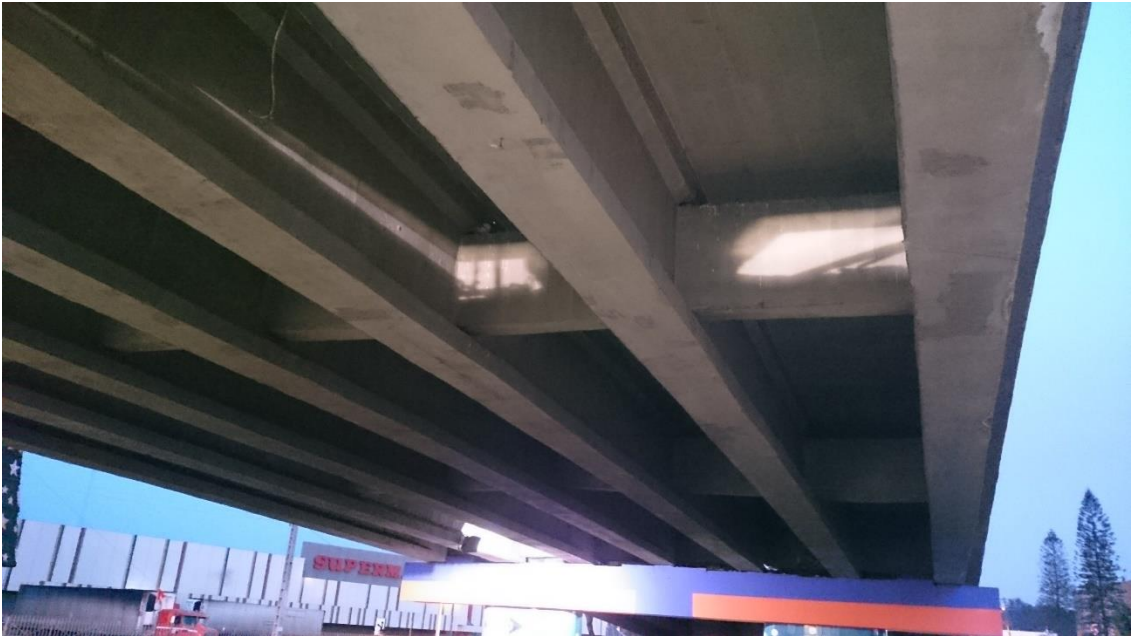
Figura 1: Vista inferior del puente frente a C.C. San Marino
