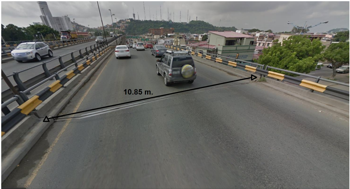
Figura 12: Separación entre vigas de puente en La Atarazana
