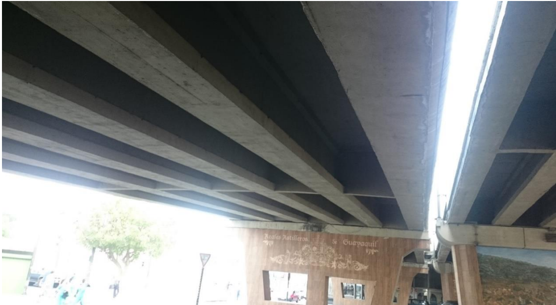
Figura 8: Vista inferior de puente en La Atarazana
