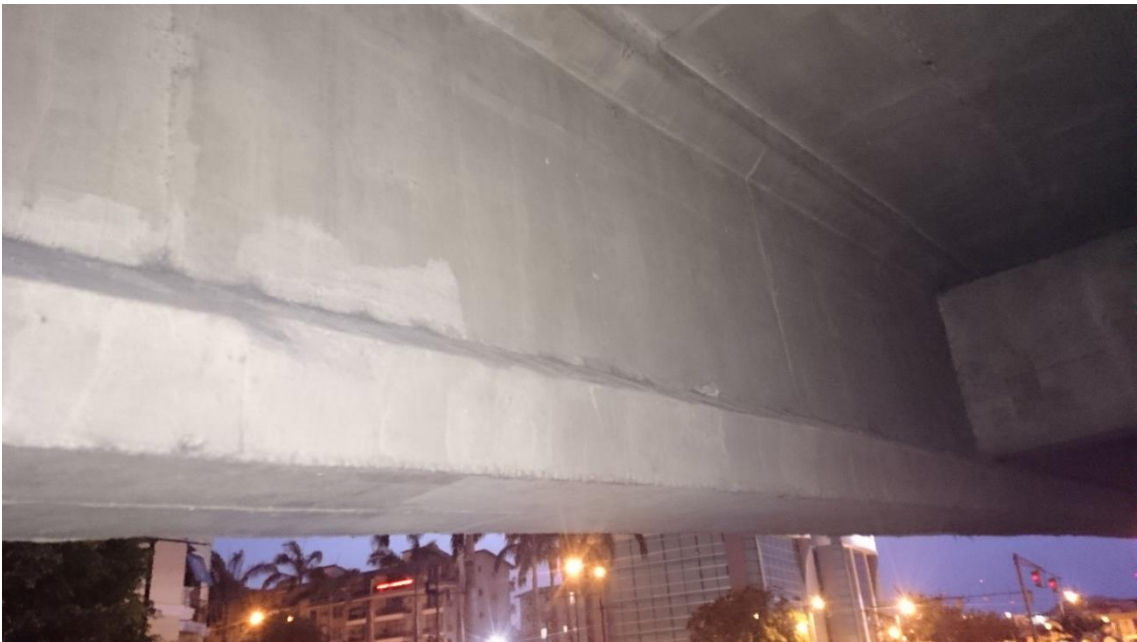
Figura 2: Vista cercana de vigas en puente frente al C.C. San Marino
