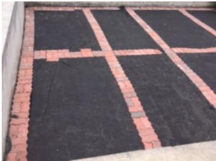
**Ilustración 23.** Celda de deshidratación de la PTARD.
