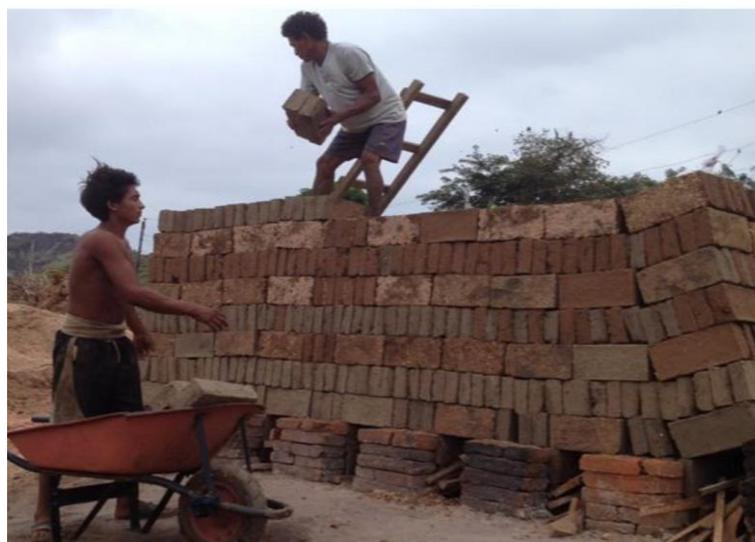
**Ilustración 28.** Armado de horno artesanal (pirámide de cocción). Fuente: Tesis de Grado de Ing. Xavier Orellana (2015).
