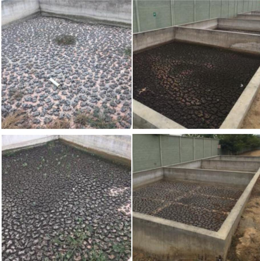
**Ilustración 24.** Lodos residuales en diferentes niveles de deshidratación. Fuente: Ing. José Perú, Codemet (2016).
