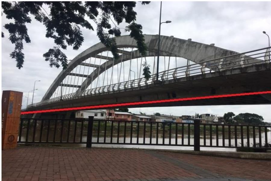
Figura 3. 13: Recorrido de la fibra óptica por el puente sobre el río San Pablo.
