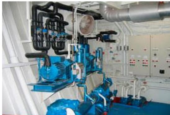
Figura 2. 12: Sistema de refrigeración para barcos.
