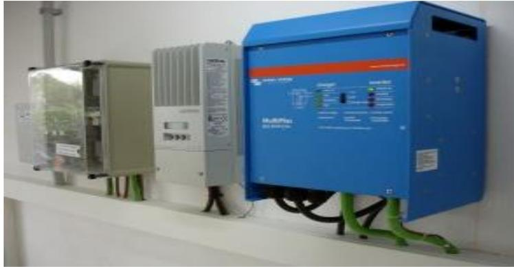
Figura 2. 16 Regulador Fotovoltaico
