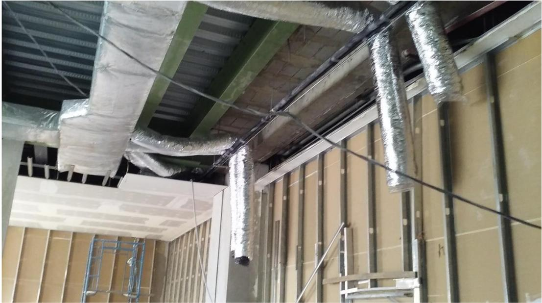
Anexo 3: Ductos y mangas flexibles del sistema A1 VRF.
