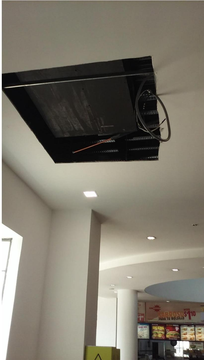
Anexo 6: Unidad evaporadora Fan - Coil de 96 KBTU/H del sistema A1 VRF.
