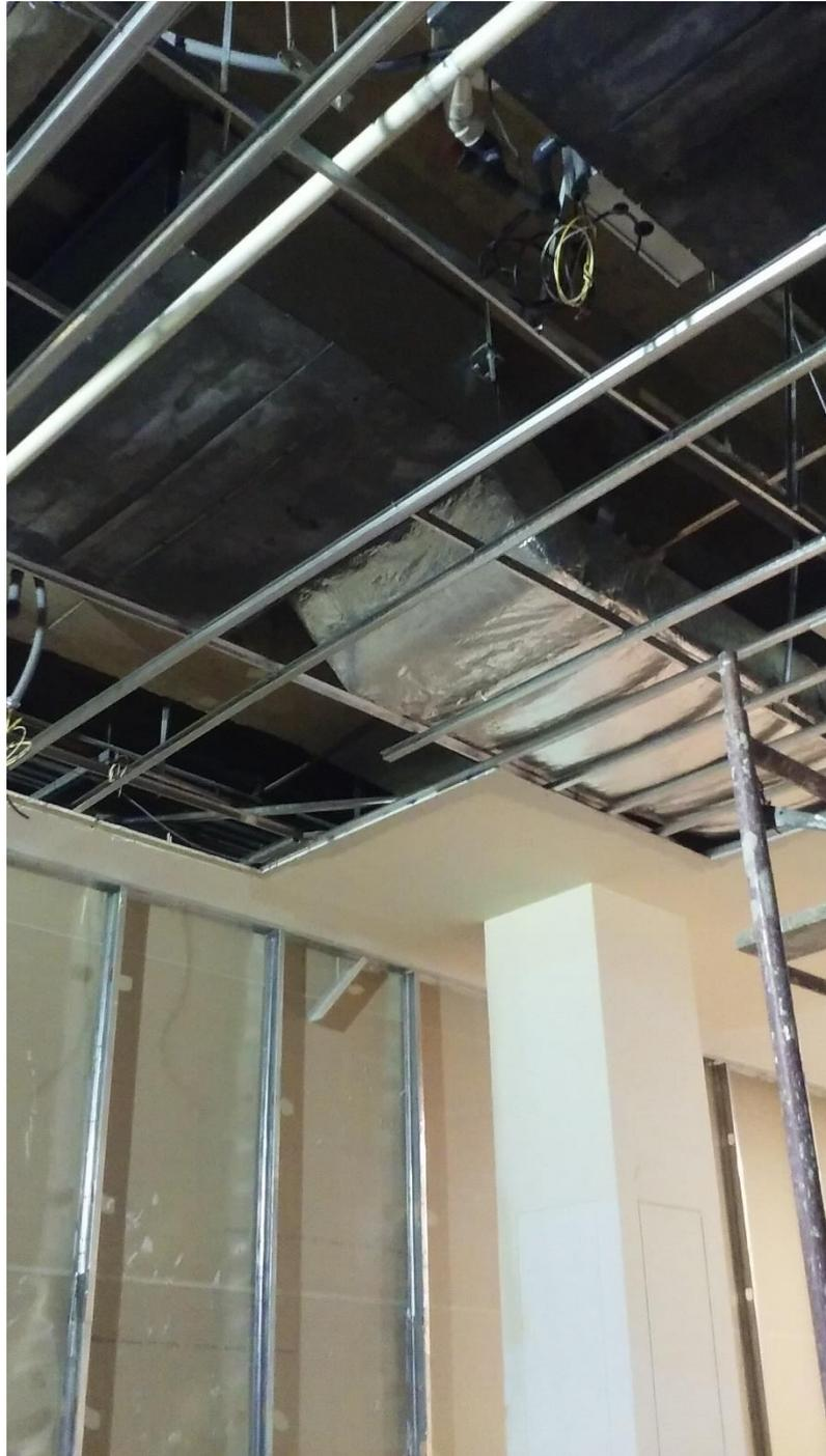
Anexo 5: Unión entre máquina evaporadora y ductos.
