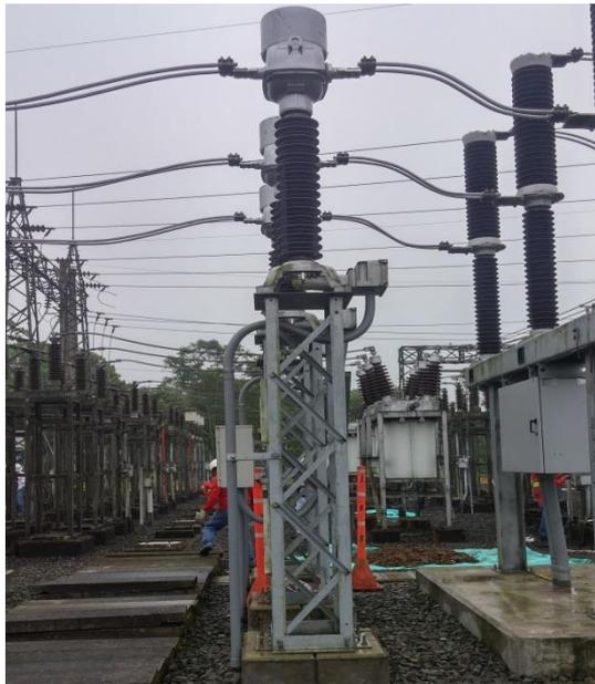
**Figura 3. 15 Transformador de corriente**
