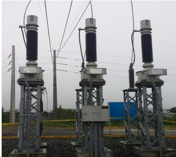
**Figura 3. 14 Transformador de tensión**
