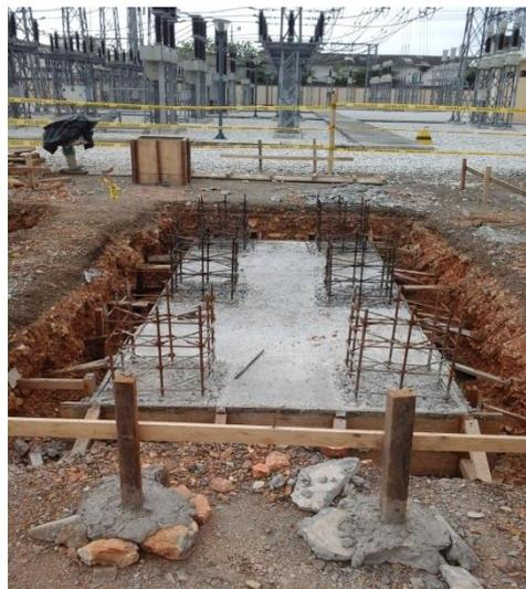
**Figura 5. 6 Cimientos para Transformador de Poder**
