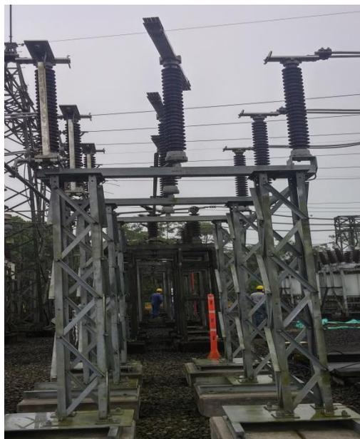
**Figura 3. 13 Seccionador de tres columnas con apertura central**
