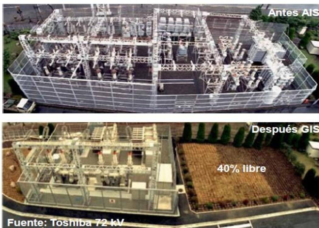
**Figura 4. 7 Reemplazo de una subestación AIS por una GIS**
