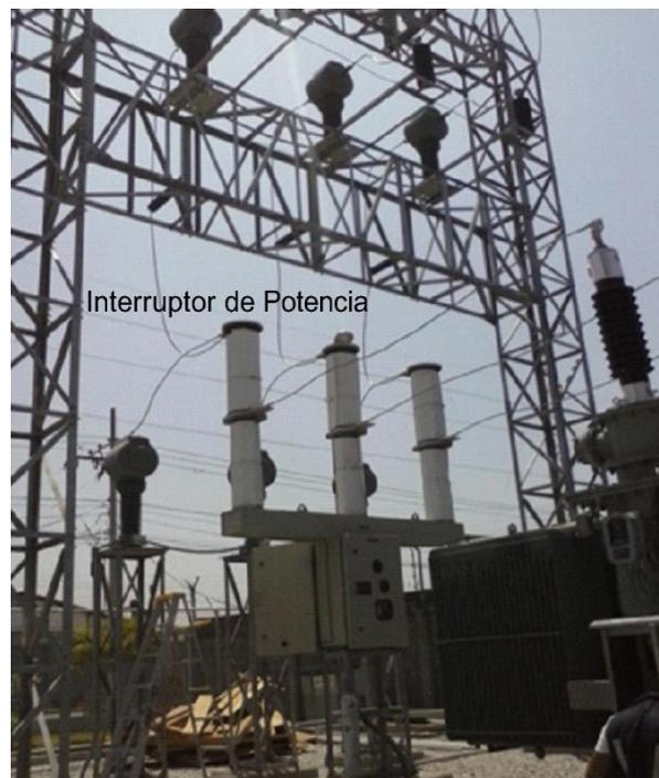
**Figura 3. 11 Interruptor de potencia**
