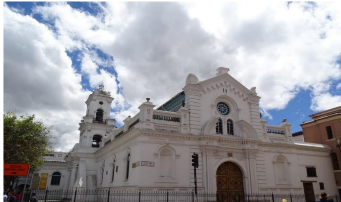
Figura 36. Iglesia del Sagrario. Tomado de Google. Recuperado de https://www.google.com.ec/search?q=iglesia+del+sagrario+cuena&biw=1517&bih=735&source=lnms&tbm=isch&sa=X&ved=0ahUKEwriet_m4z57RAhWIMyYKHdh-CVQQ_AUIBigB#imgrc=cmwZJFW5uqqFWM%3A
