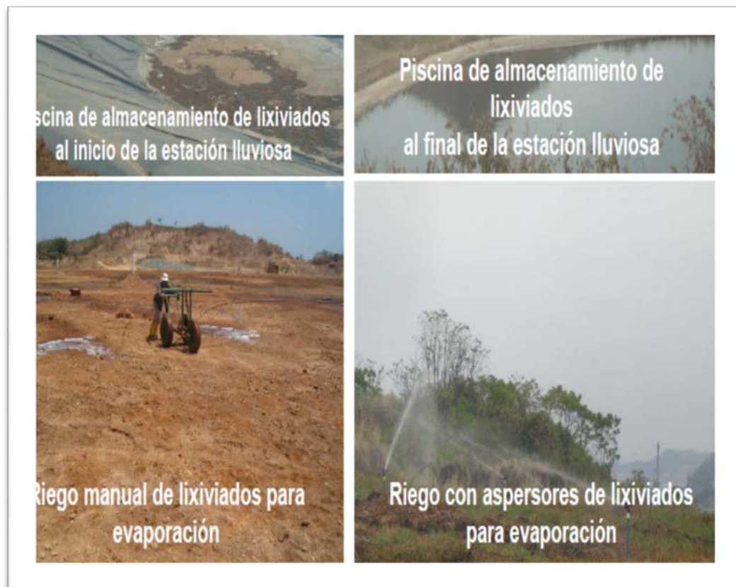
Figura 13. Manejo y eliminación de lixiviados mediante tratamiento de evaporación.
