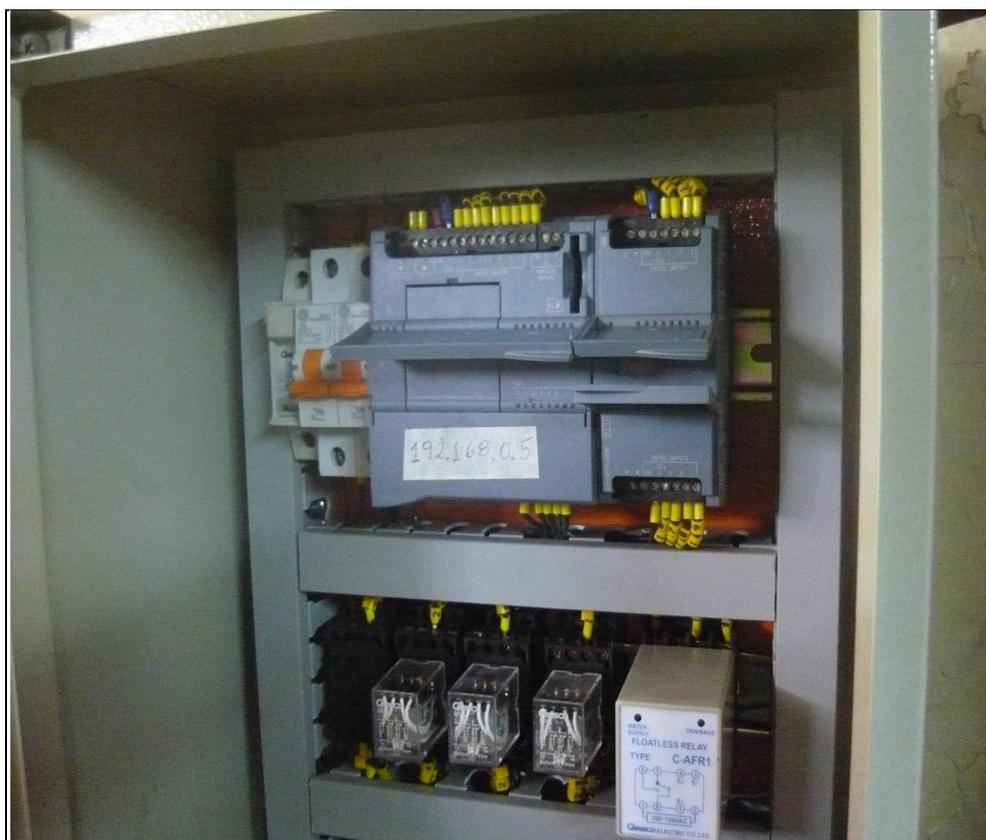
**Figura 5-8 Conexiones finalizadas del PLC en cuarto de bombas (cisterna)**
