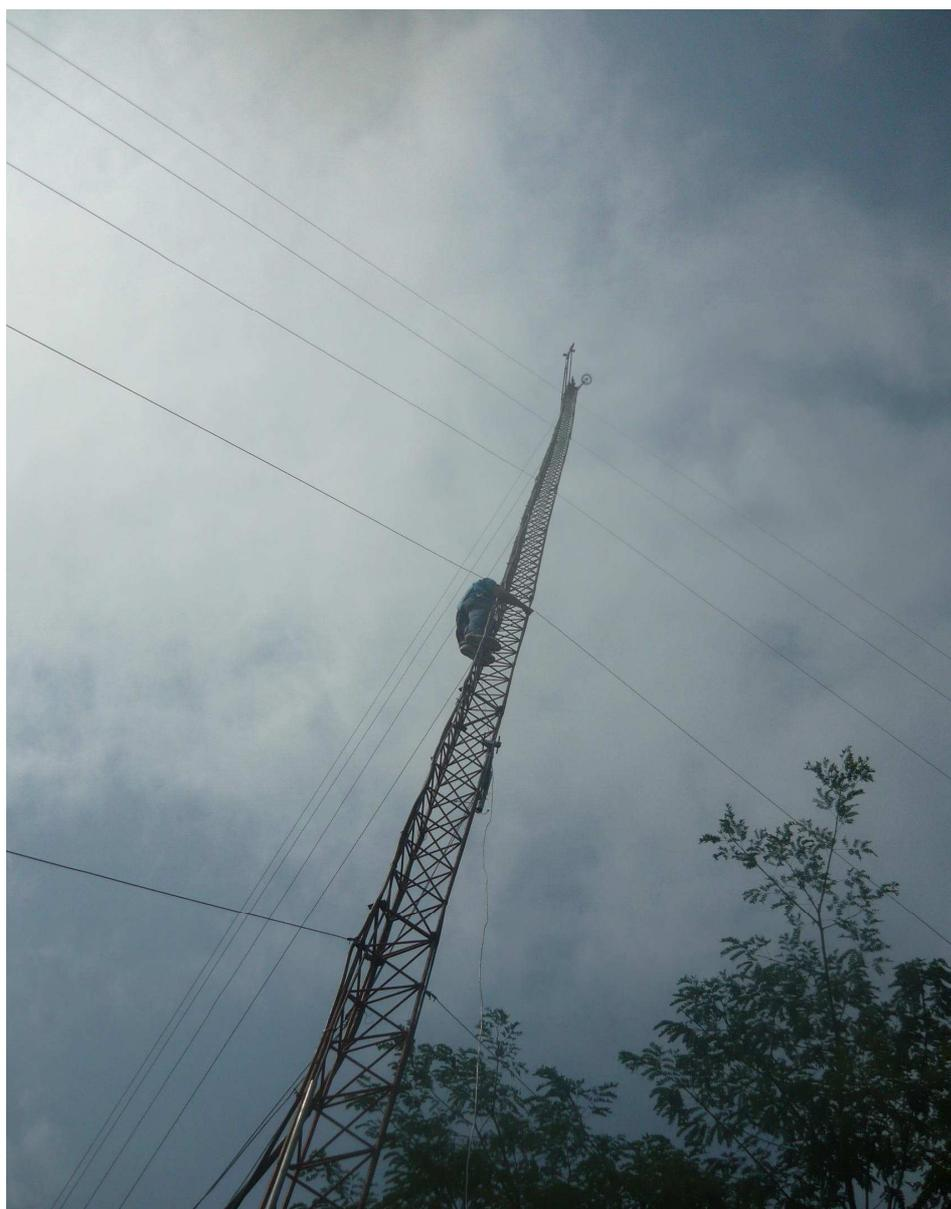
**Figura 5-12 Instalando equipo Nanostation (transceptor a 5.8 GHz)**
