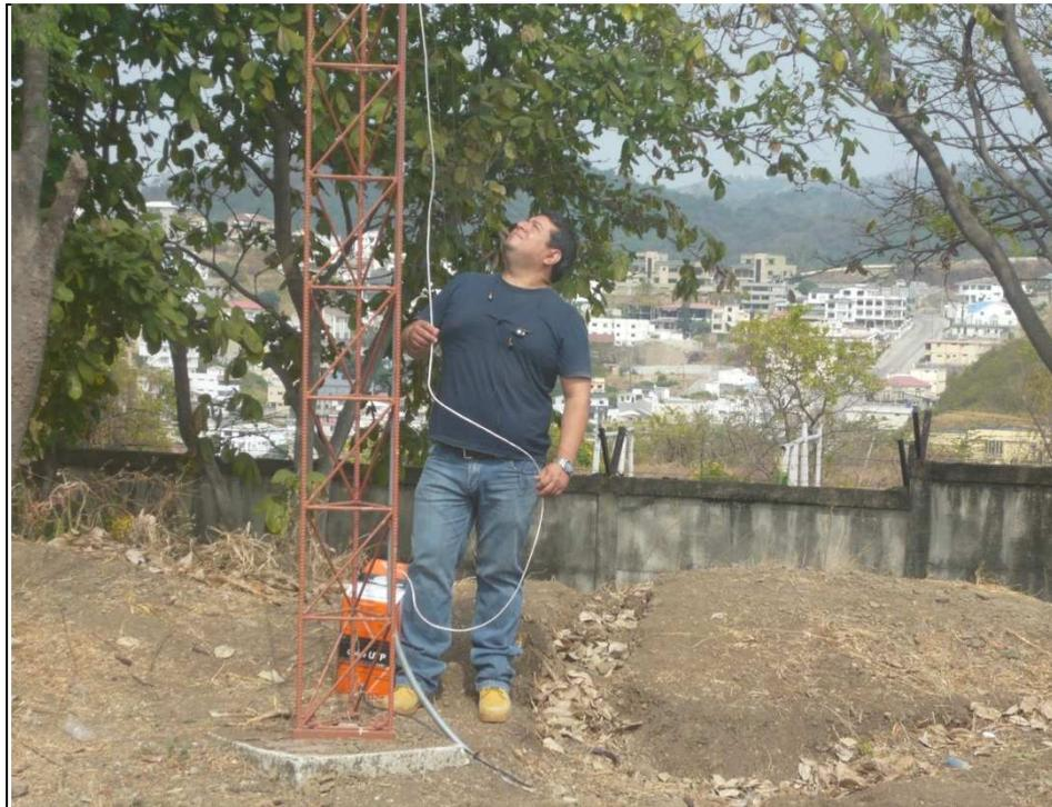
**Figura 5-11 Bajando cable de red de la antena Nanostation para enlace inalámbrico (torre de arquitectura hacia cuarto de bombas)**
