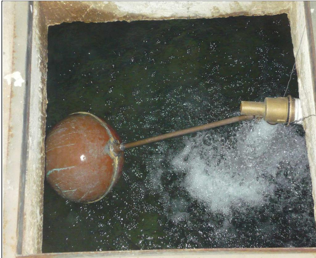
**Figura 5-2 Sensor mecánico (boya) para el llenado de cisterna en UCSG**
