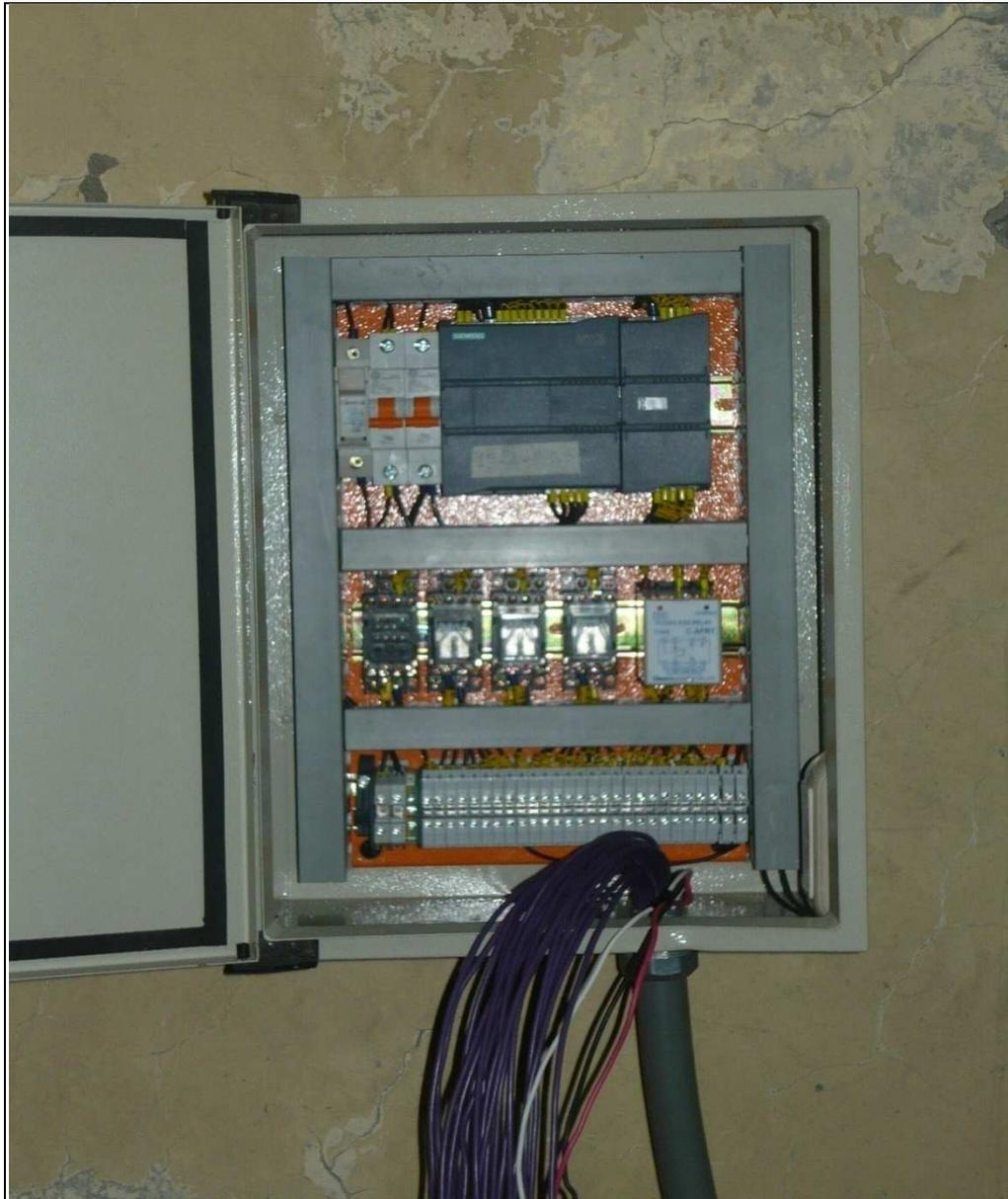
**Figura 5-6 PLC Simatic S7-1200, cableado hacia tablero de Control eléctrico**
