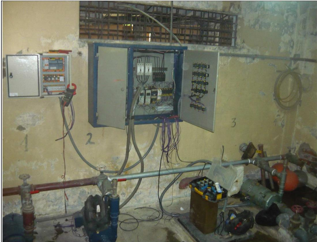
**Figura 5-5 Tablero eléctrico mas el sistema PLC-Simatic 1200 (caja blanco)**
