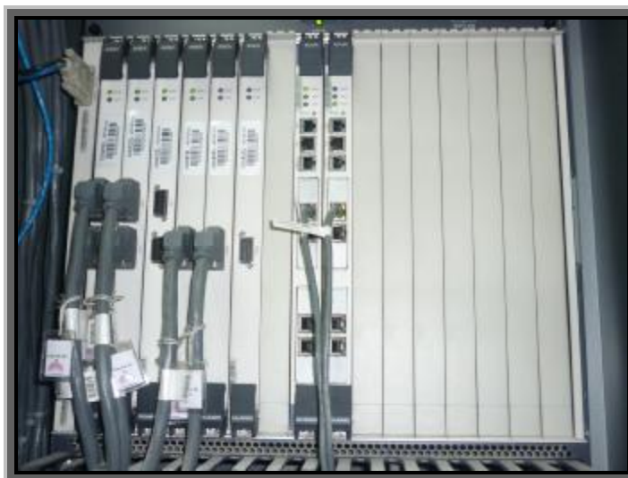
Figura 55: Softswitch SoftX3000 de Huawei (13)
