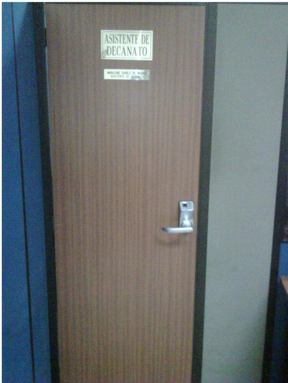
**Figura 4-18 Nueva cerradura biométrica instalada**
