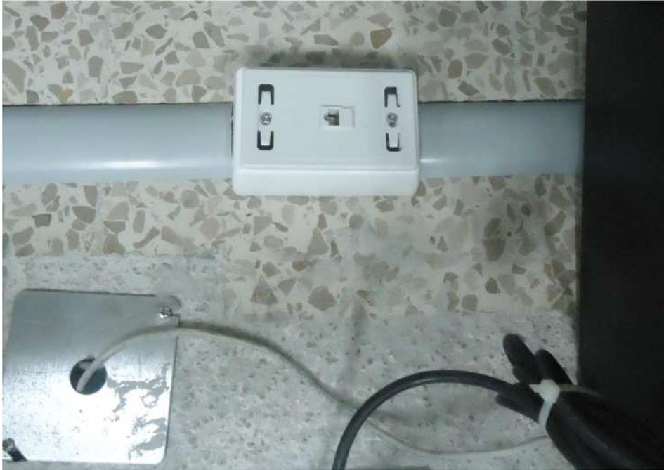
**Figura 4.4: Terminación de uno de los puntos de red instalados junto a las computadoras**
