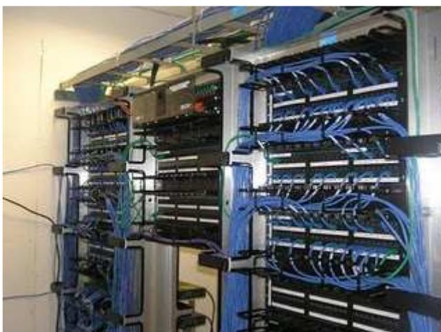
**Figura 2.20: Bastidor para rutas de cableado horizontal.<sup>26</sup>**
