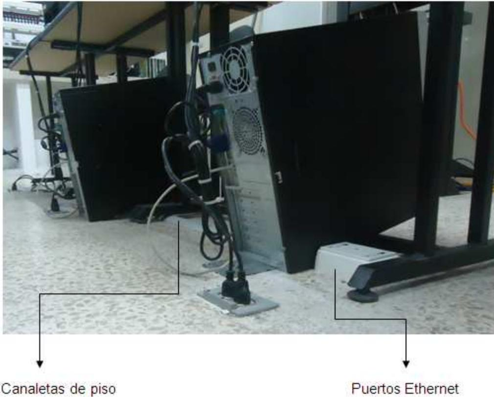
**Figura 4.3: Vista lateral de los puntos de red colocados junto a las computadoras.**
