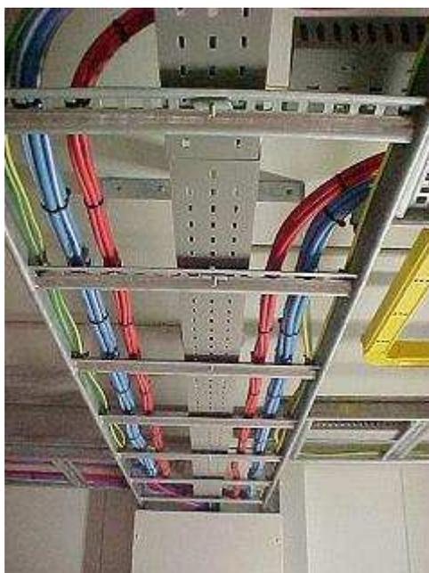
Figura 2.25: Tipo de escalerilla para cables.<sup>31</sup>
