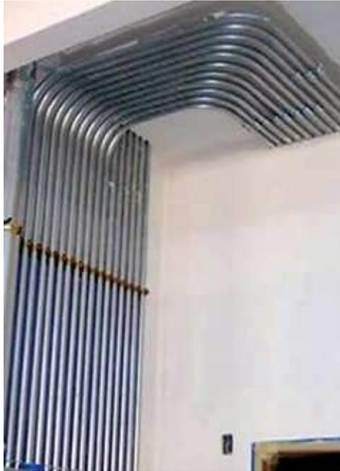
**Figura 2.22: tubería conduit para cableado estructurado<sup>28</sup>**
