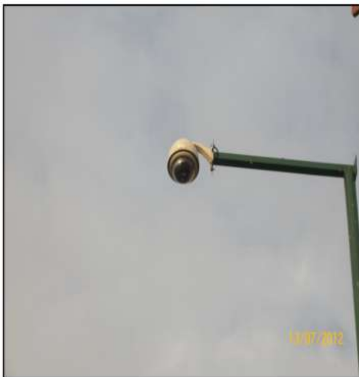
Grafico 4.9 Implementación Fase 1: Vista Lateral de Cámara PTZ
