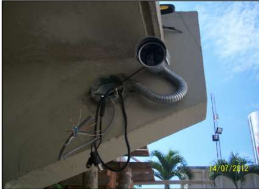
Grafico 4.12 Implementación Fase 2: Instalación de Cámara IR para exterior.
