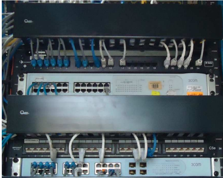
Figura 2. 17: Equipos del segundo piso del rack.
