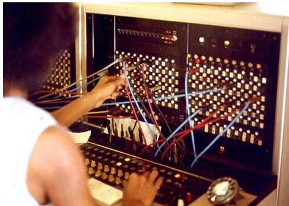
Figura 1. 1: Centralita telefónica o PBX
