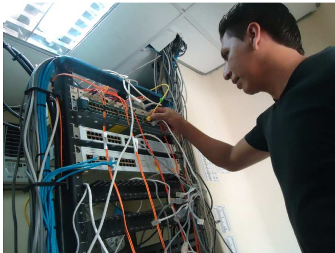
Figura 2. 14: Conexión mediante cable en el switch principal (1).
