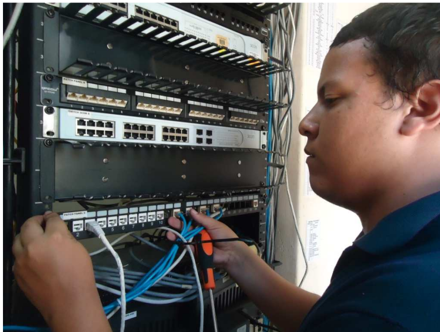
Figura 2. 25: Conexionado de cables a puertos en patch panel C (2).
