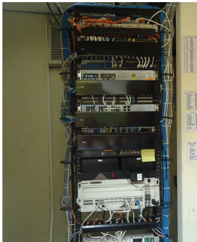
Figura 2. 30: Fin de instalación en el rack de la FET (2)
