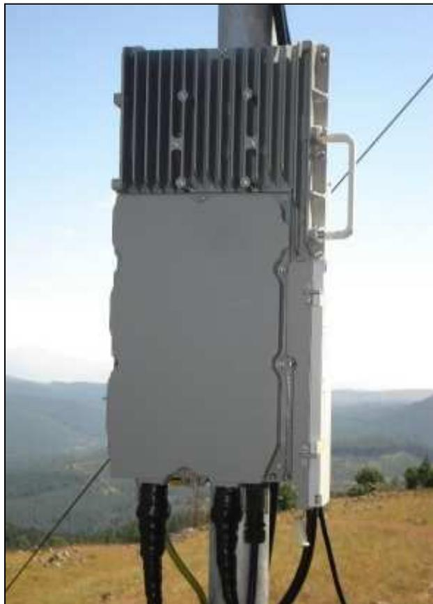
**Figura 3.12 NODO B DE HUAWEI**
