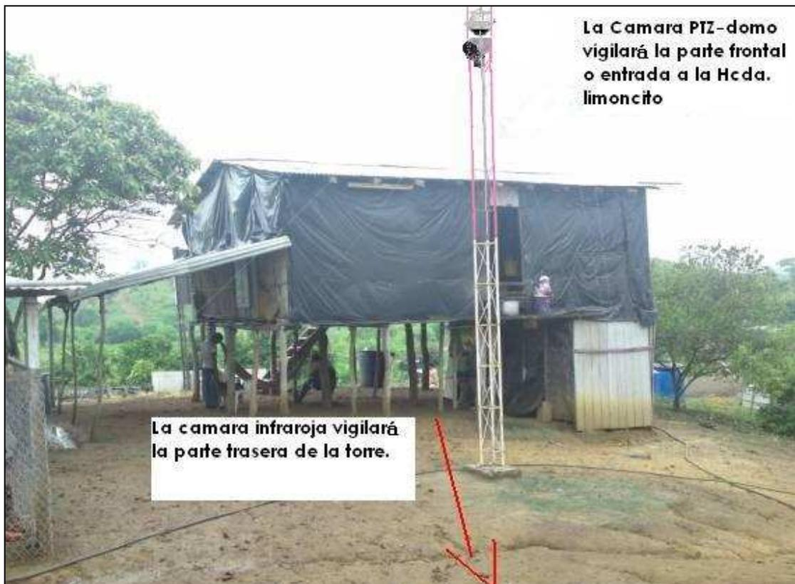
**Figura 4.4 Instalación de las cámaras de video en la torre de Limoncito**
