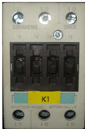
**Figura 5.21** Contactor Trifásico Siemens 35Amp.
