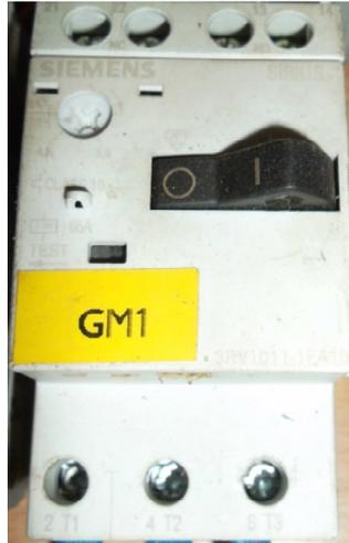
**Figura 5.20** Guardamotor trifásico.
