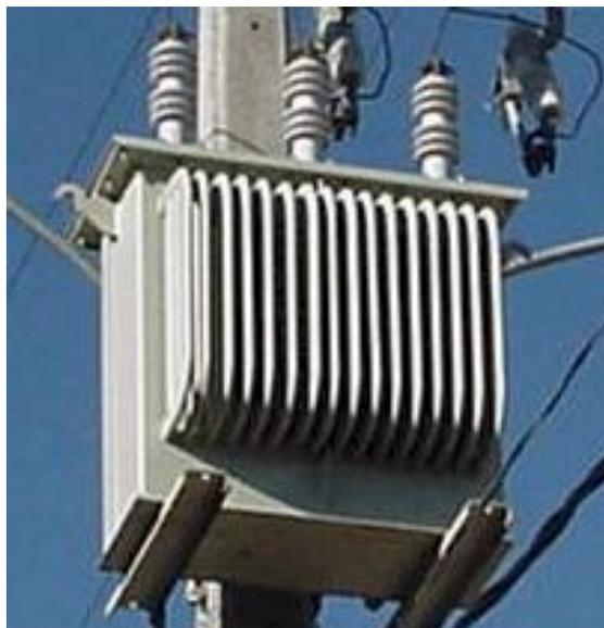
**FIG. 3.6 TRANSFORMADOR AUTOPROTEGIDO TRIFÁSICO**
