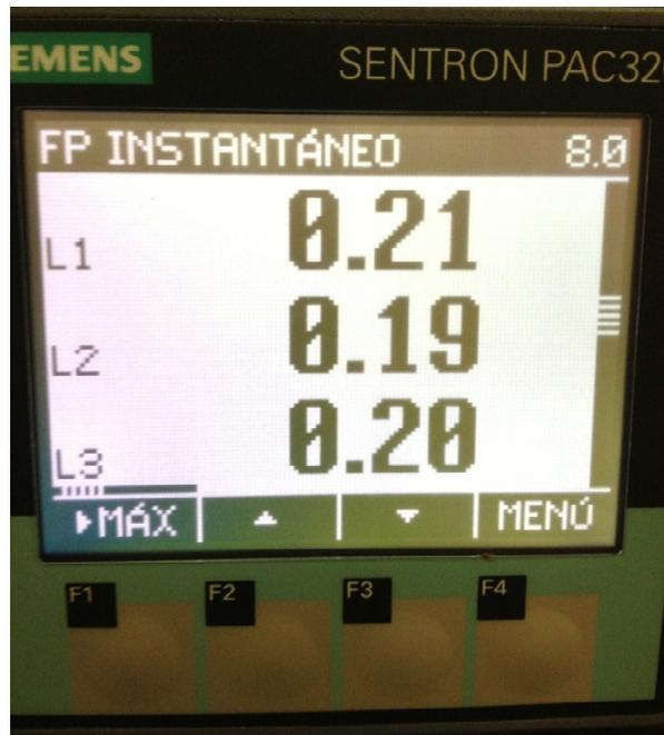
Fig. 4.1.18 Medición del FP por línea del motor con SentronPac 3200
