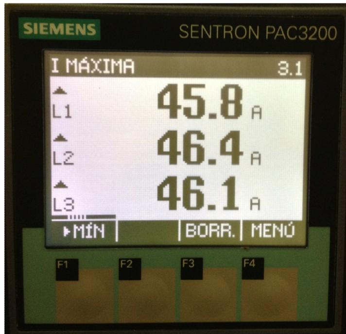
Fig 4.1.14 Medición de corriente de arranque del motor
