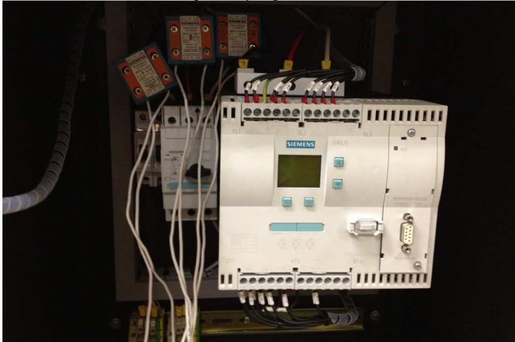
Fig 4.1.4 Instalación de TC
