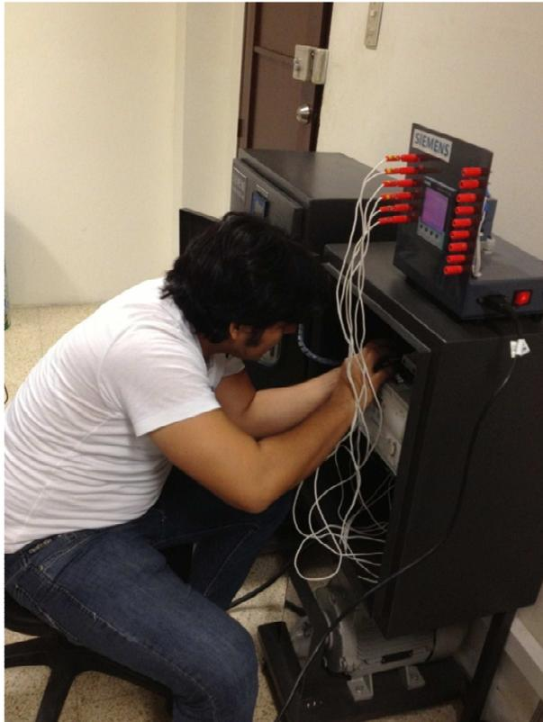
Fig. 4.1.8 Conexión de TC con SentronPac 3200
