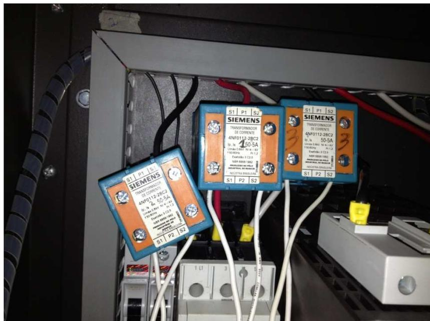
Fig 4.1.5 Instalación de TC
