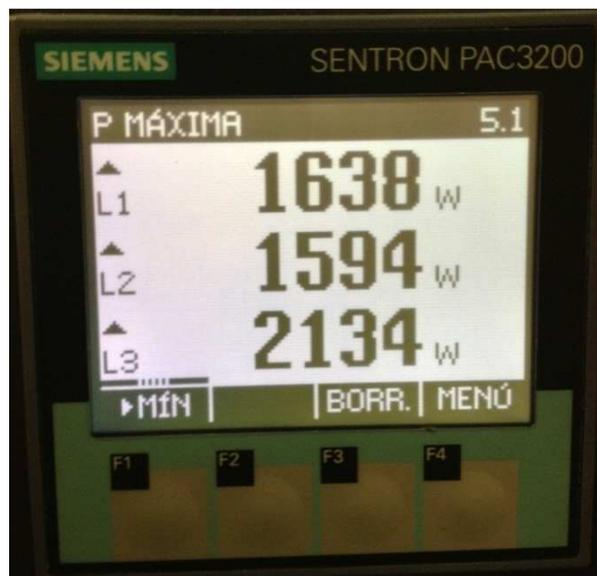
Fig 4.1.15 Medición de potencia activa del motor
