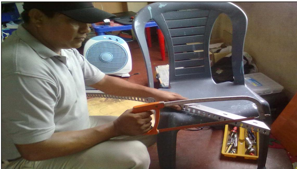
**Figura 3.36 Corte de canaleta ranurada.**
