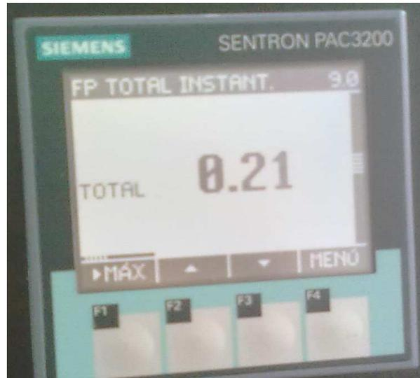
**Figura 4.6 Medición de bajo factor de potencia**
