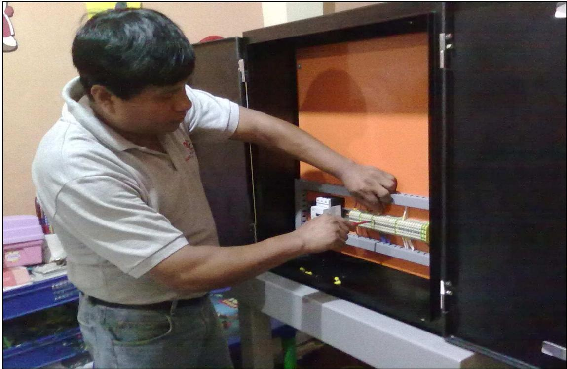
**Figura 3.40 Conexión de L1+ y Masa a borneras.**
