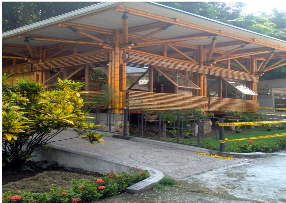
Sala de Lectura de Arquitectura (en construcción)
