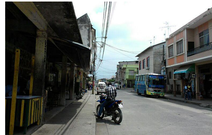
Figura 44: Alumbrado público y edificaciones en mal estado en la vía General Córdova. Autora 2013
