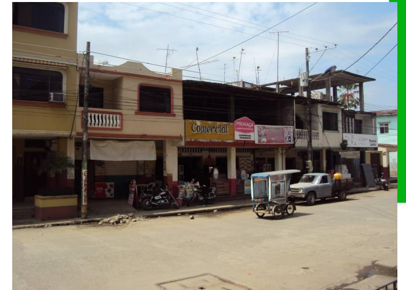
Figura 40: Elementos que distorsionan la imagen urbana. Cables y letreros.
