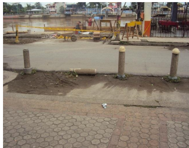
Figura 42: Bolardos frente al Malecón en mal estado. Fuente: Autora 2013
