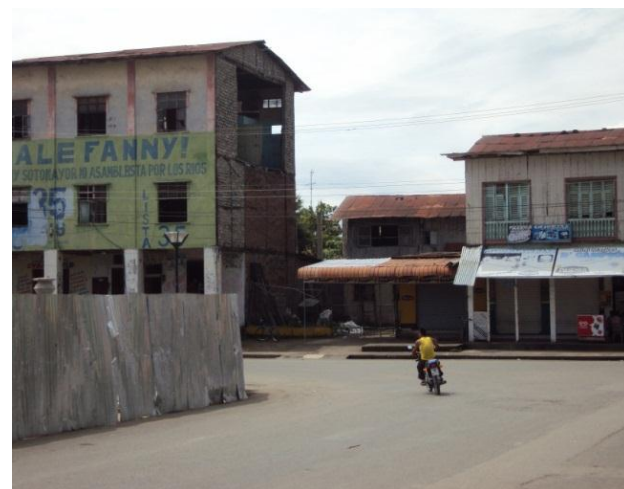
Figura 43: Edificaciones en mal estado en la vía 9 de octubre. Fuente Autora 2012
