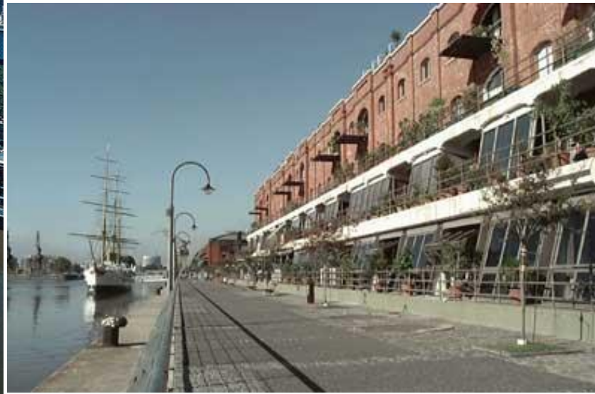
Figura 61: Pasarela junto a locales comerciales.
