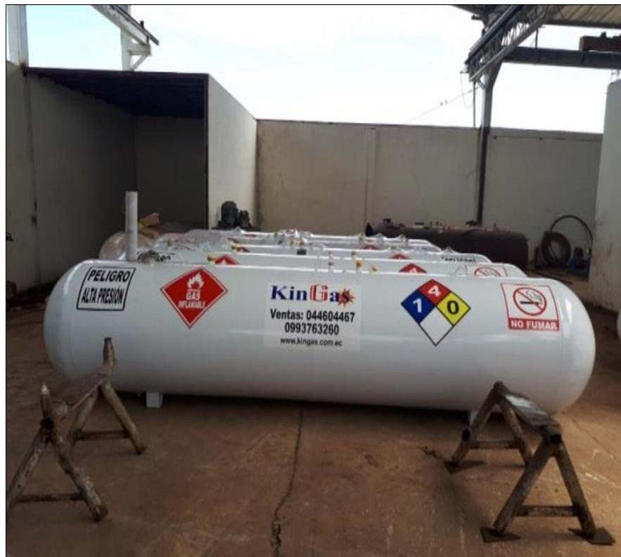
Figura 3. Tanque de 2000kg (4m<sup>3</sup>) con dos costuras.
