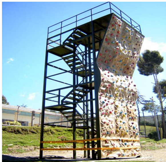
Figura 32. Torre para escala obtenida de Pagina Web Muro Construcciones.
