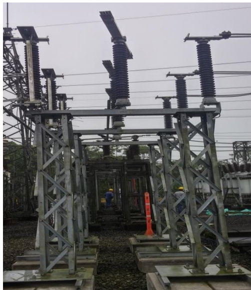
Figura 2. 10 Seccionador de tres columnas con apertura central
