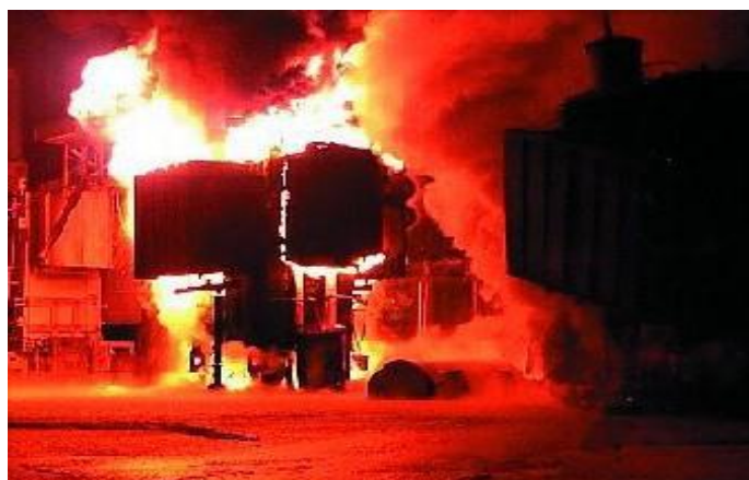
Figura 2. 32. Explosión del transformador de potencia
