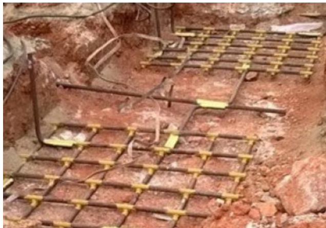
Figura 2. 30 Sistemas de puesta a tierra para subestaciones
