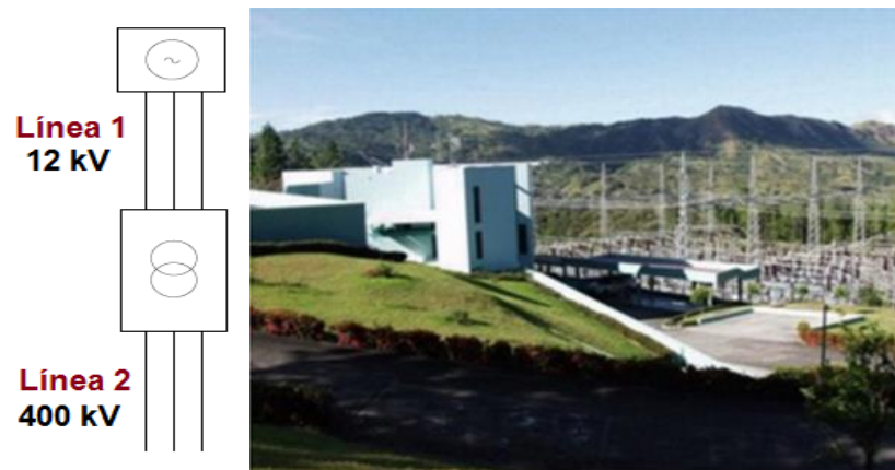
Figura 2. 4. Subestación eléctrica tipo Central
