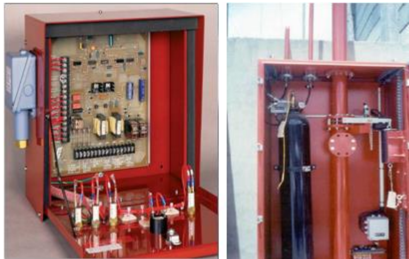
Figura 4. 7. Gabinete o panel de control (izq.) y panel con accesorios de SCI
