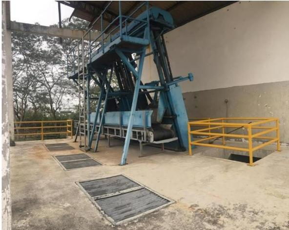
**Fotografía 5** Vista de las rejillas con limpieza automática y manual
