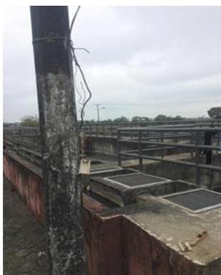
**Fotografía 32** Puntos eléctricos sin protección y sin los interruptores
