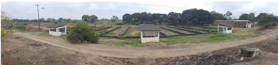
**Fotografía 20** Los lodos regados en los lechos de secados
