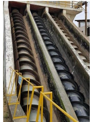
**Fotografía 31** Ala lateral de los tornillos en estado de corrosión
