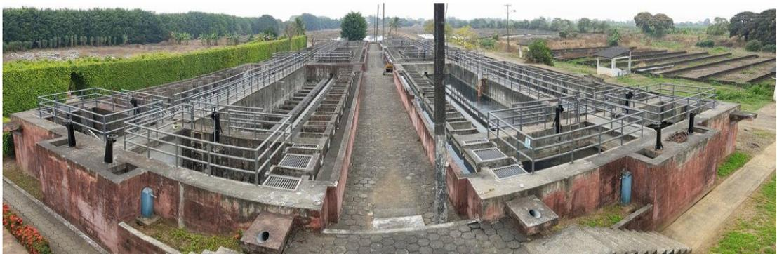
**Fotografía 11** Vista de los 6 reactores UASB
