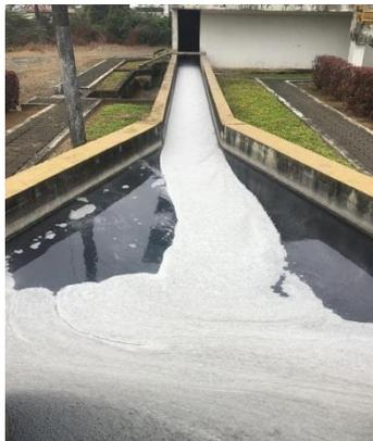
**Fotografía 9** Salida del agua residual de las cámaras de rejillas
