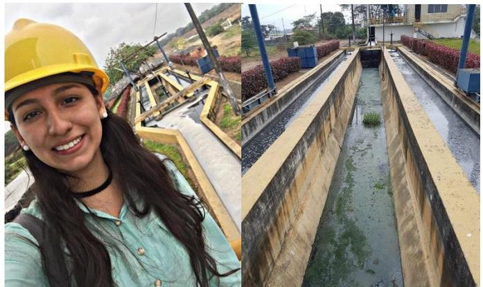
**Fotografía 8** Llegada del agua residual al desarenador principal y a los 2 secundarios
