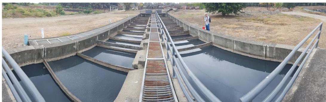
**Fotografía 14** Llegada del agua residual tratada por el UASB a los tanques de flotación
