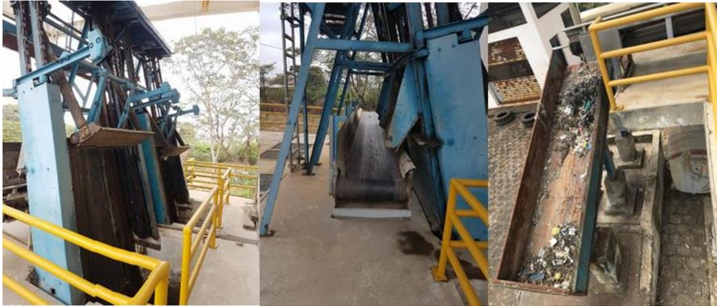
**Fotografía 7** Cámaras de rejillas automáticas con la banda transportadora
