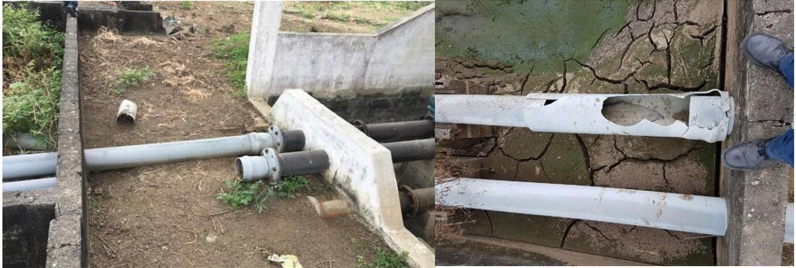
**Fotografía 42** Tuberías desaparecidas y rotas en ciertas partes de los lechos de secado
