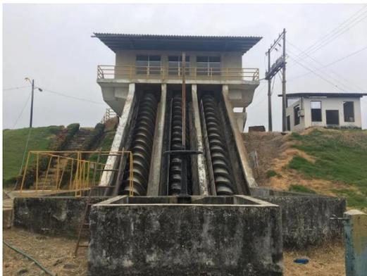
**Fotografía 2** Vista frontal de los tornillos de Arquímedes
