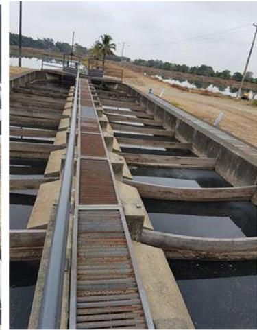
**Fotografía 38** Rejas en estado de descomposición por el ambiente corrosivo.
