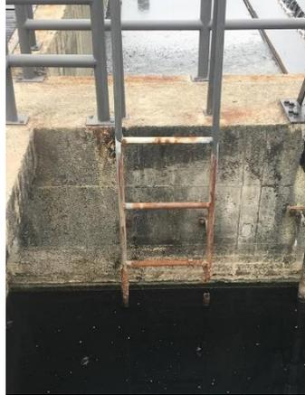
**Fotografía 36** Escalera de los reactores en estado de descomposición.
