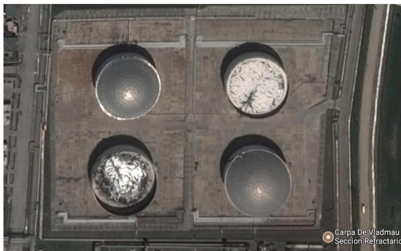
Figura 3. 1: Tanques de almacenamiento de combustible.
