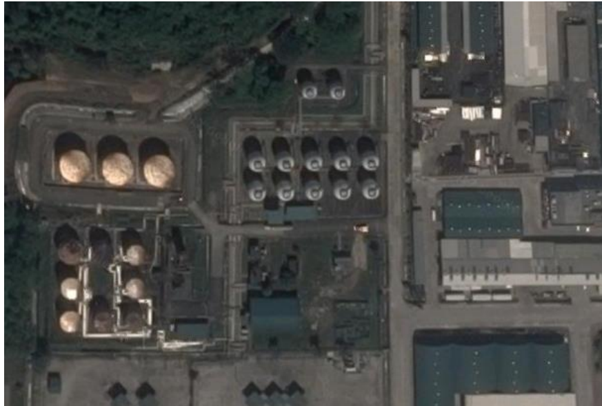
Figura 3. 2: Campo de tanques de almacenamiento de GLP. Elaborado por: Autor.
