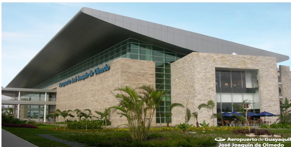
Figura 12. Foto fachada Aeropuerto José Joaquín de Olmedo
