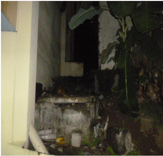
Figura # 41 Vía que conduce al cuarto de generador (Noche) Fuente: Autor
