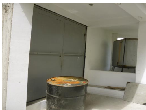
Figura # 35 Cuarto de Generador de Radio y TV
