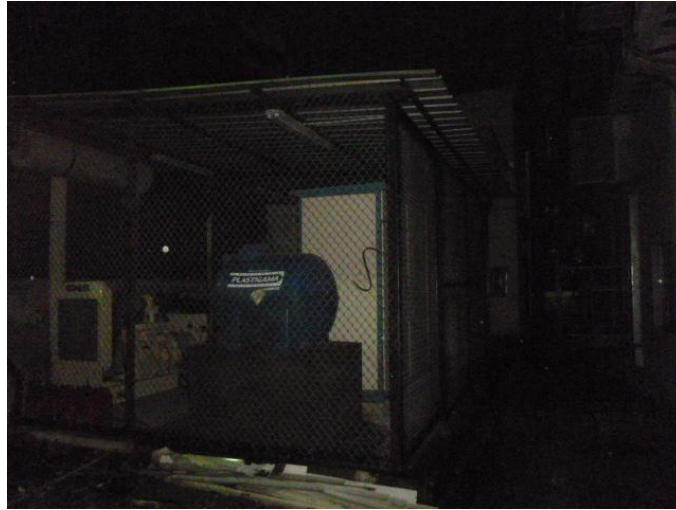
Figura # 45 Vía que conduce al generador (Noche) Fuente: Autor
