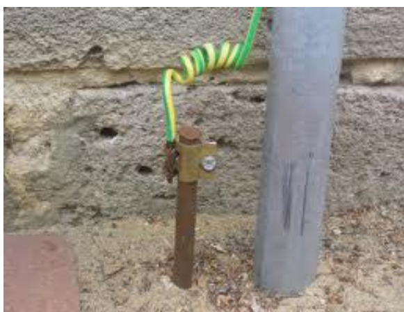
Figura # 10 Conductor de puesta a tierra utilizando abrazadera
