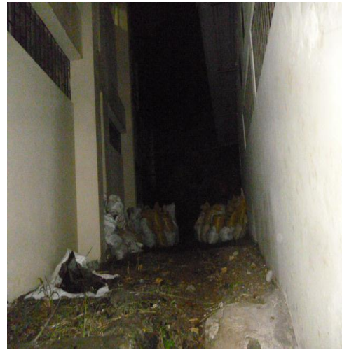
Figura # 42 Entrada al cuarto de generador Fuente: Autor
