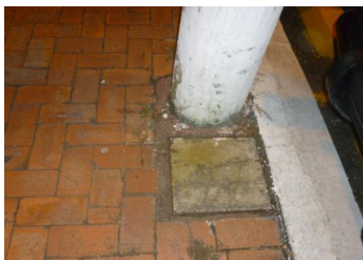
Figura # 6 Caja de Revisión
