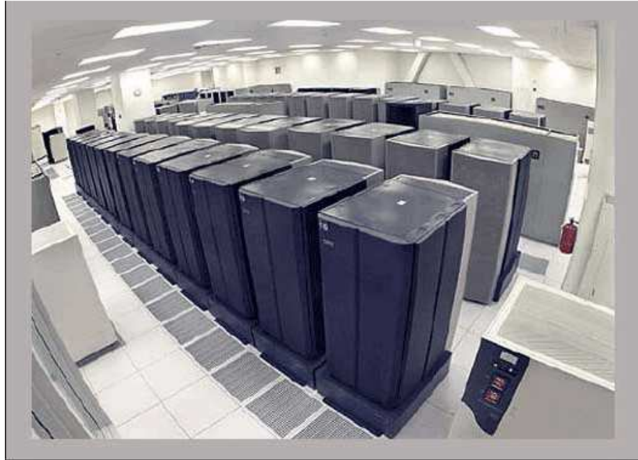
Sala de TI
