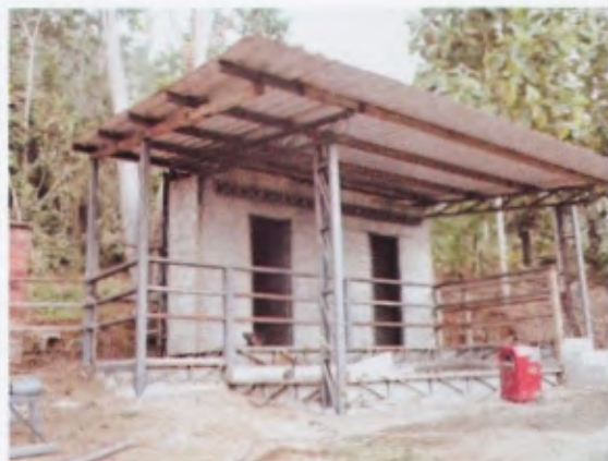
Foto N° 44: Vestidores de ingreso a granja terminados (con BPA).
