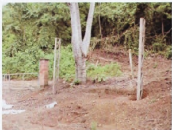
Foto N° 43: Construcción de vestidores de ingreso a granja (sin BPA).
