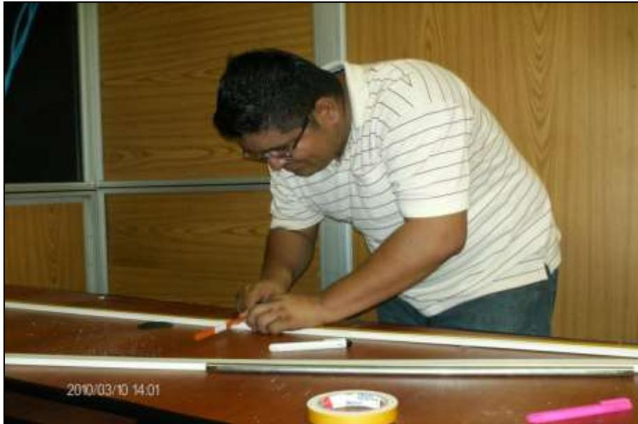
**Fig. 5-8 Preparación y Corte de canaletas para cubrir los cables de red**
