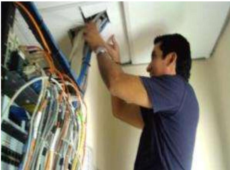
**Fig. 5-4 Conexión desde el switch y cableado por el tumbado del cuarto de equipos**
