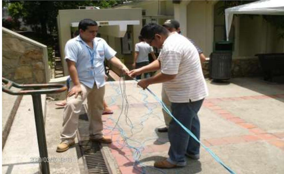
**Fig. 5-2 Tensado de cables de red**
